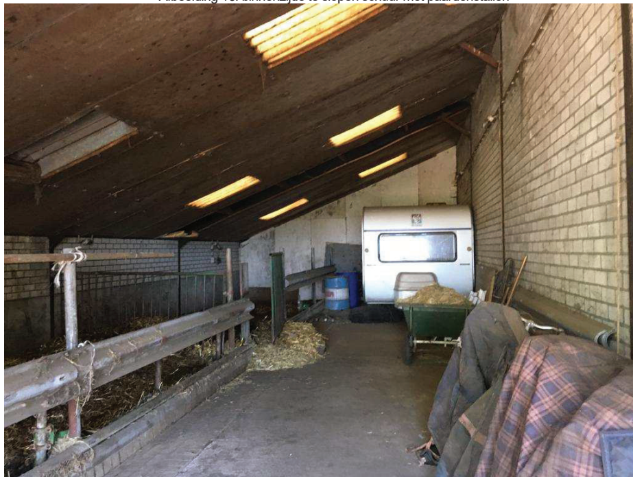
• Afbeelding 16: binnenzijde te slopen schuur met paardenstallen
