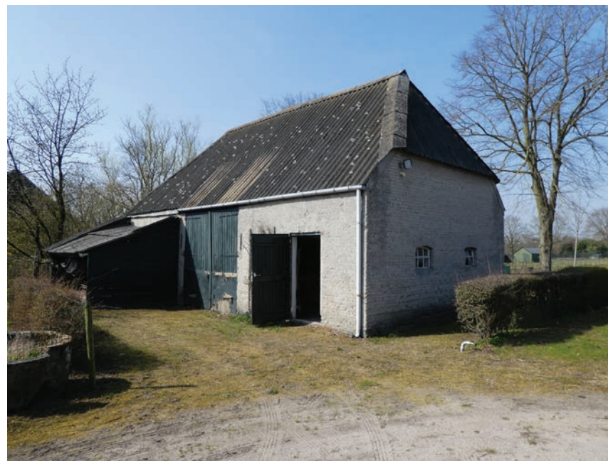
Dwarsdeel-schuur, aanzicht vanaf het erf.
