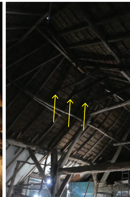
Dakconstructie boven schuur met enkele oude beroette eiken daksporenparen met hanenbalk.
