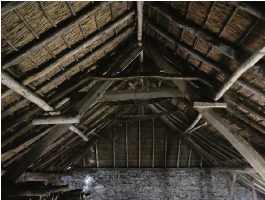
Dakconstructie boven schuur met enkele oude beroette daksporen met hanebalk.
