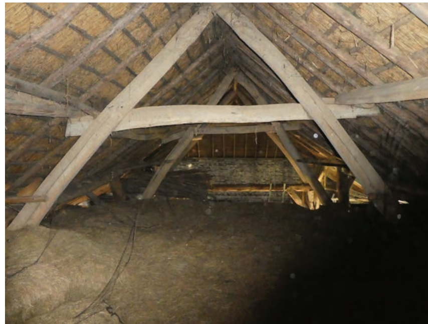
Dakconstructie boven stal.
