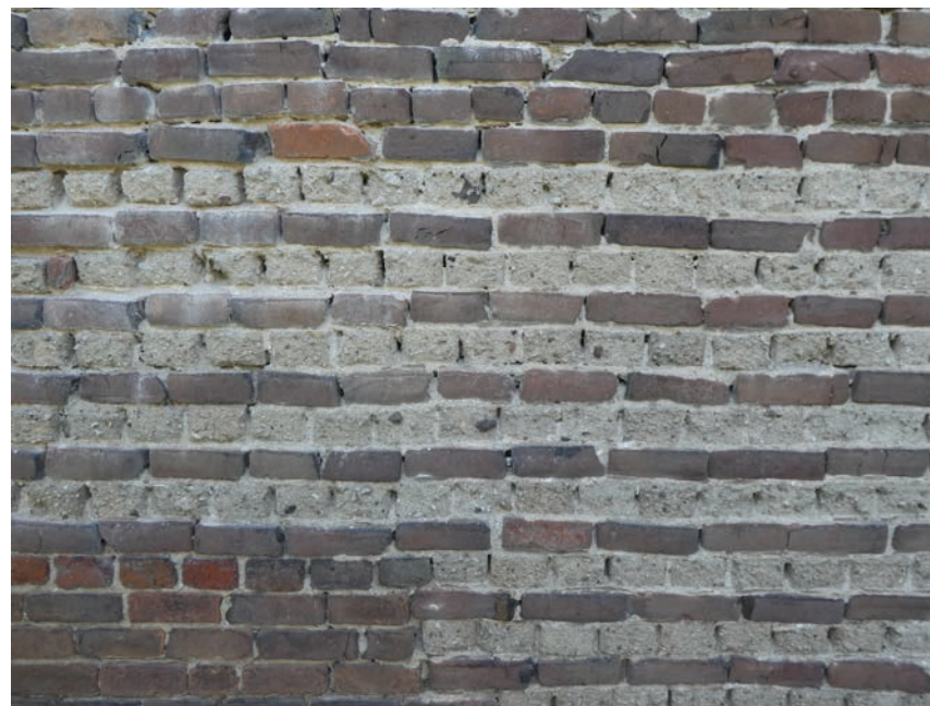
Detail van metselwerk in zijgevel.
