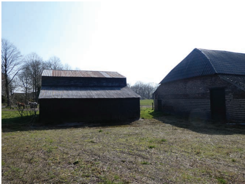
Veldschuur, exterieur noord-westzijde.
