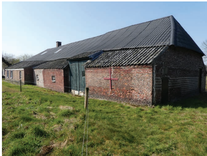
Rechterzijde van zuid-oostgevel.
