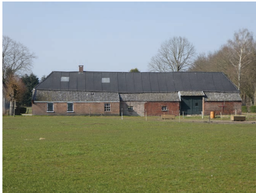
Overzicht van zuid-oostgevel.
