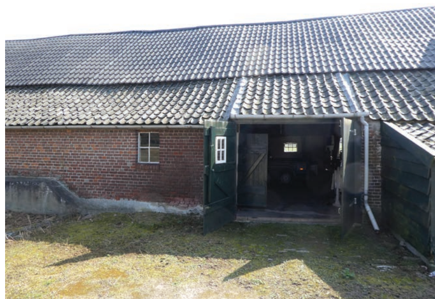
Middendeel van straatgevel.
