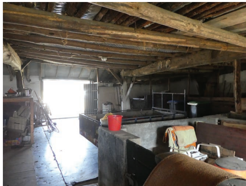
Overzicht op stalruimte, gezien richting de straatgevel.
