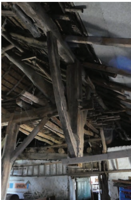
Afgezaagde gebintstijl B7 met oorspronkelijke 'staande' schoren.
