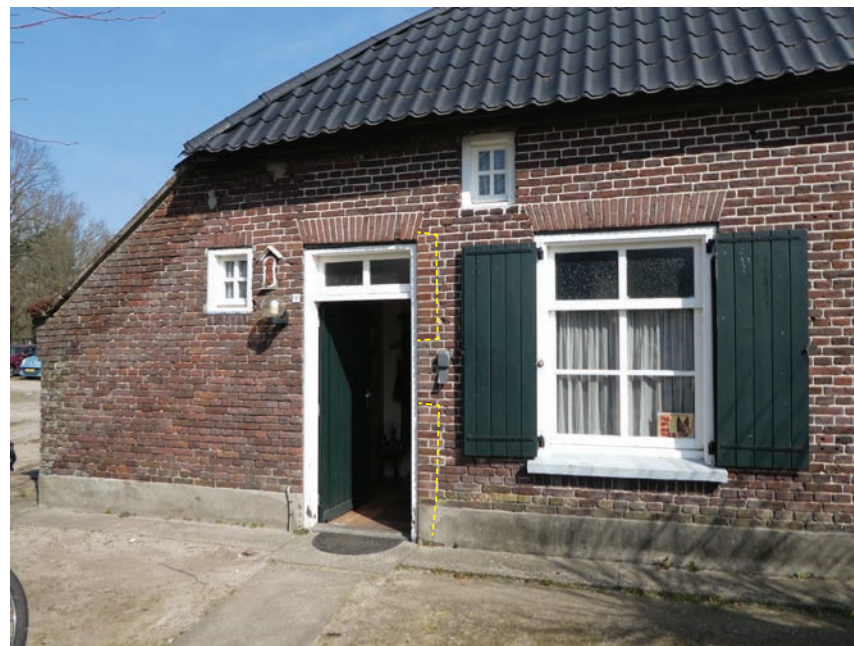
Detail van voor- of zuidwestgevel.
