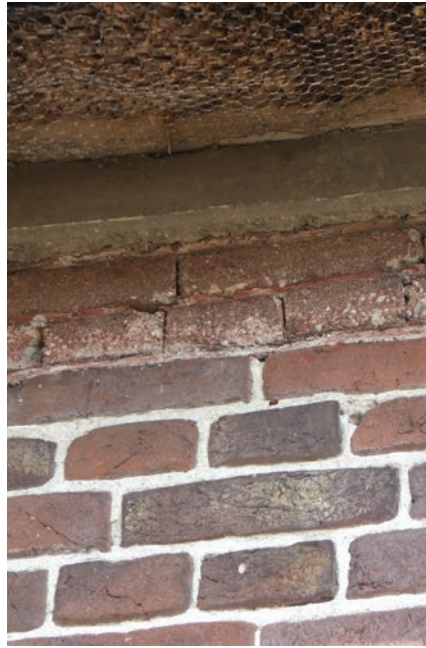
Herstellingen onder de muurplaat met gerede cementsteen.
