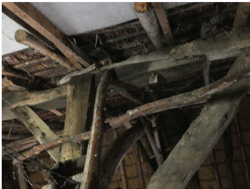
Fraaie las met toognagels en wig nabij gebinstijl C7. De linker schoor is t.b.v. de doorrit in tweede instantie hoger aangebracht.
