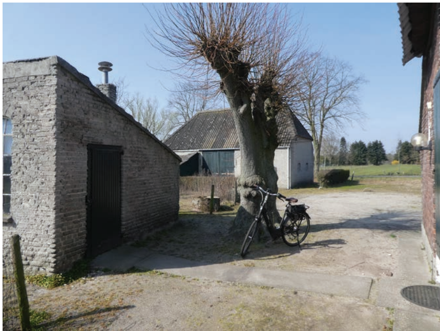
Ruimte tussen de bijgebouwen en de woning.
