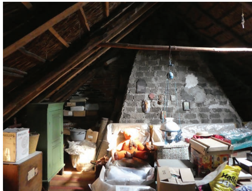
Zolder boven het woonhuis.
