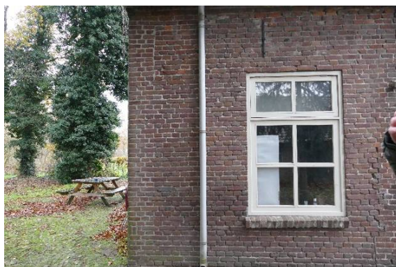
Later aangebracht venster in voorkamer
