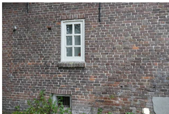
Opkamerraam en getralied raam van kelder.
