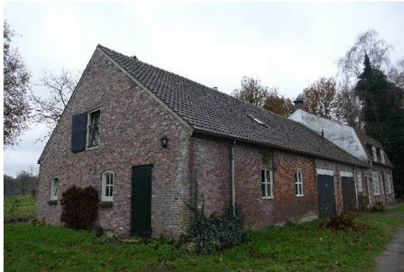
achterhuis met kopgevel
