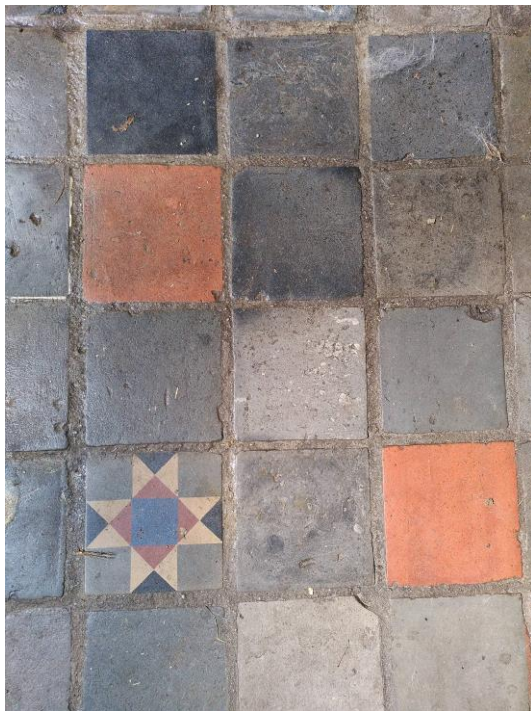
28. Tegelvloer in het halletje schuur.
