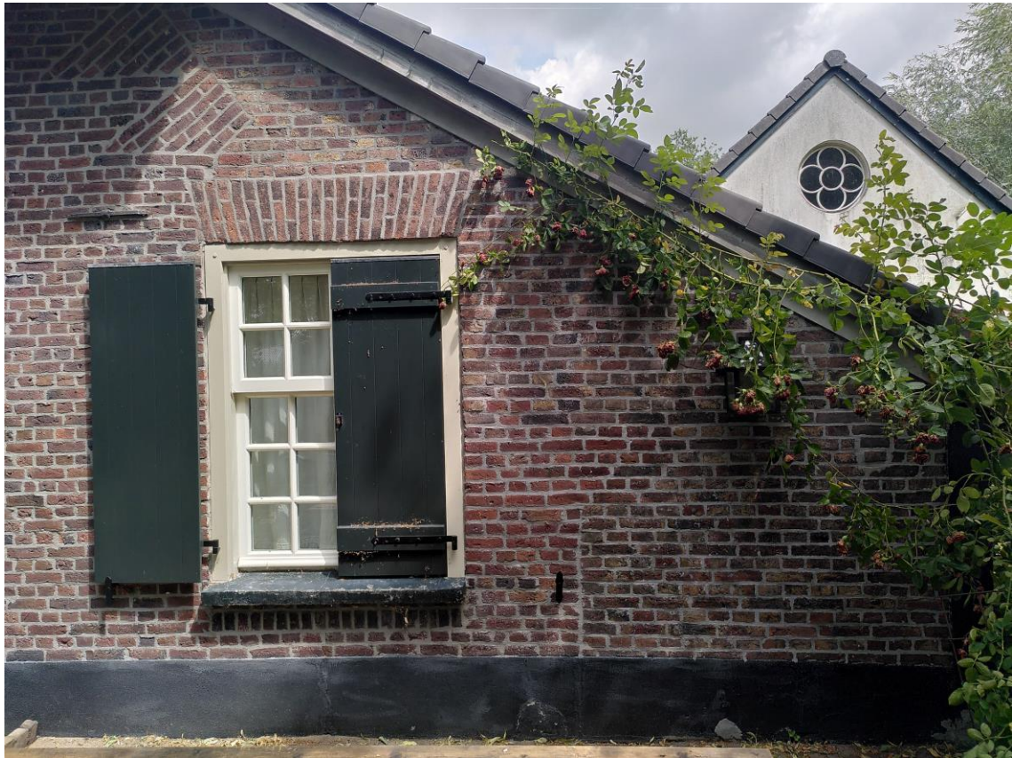
11. Kopgevel woongedeelte met bouwnaden uit de tweede bouwphase.
