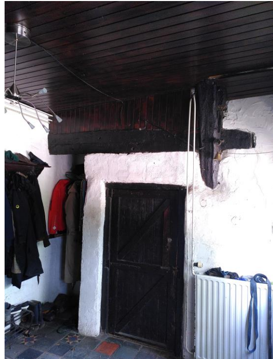
21. Restant van de scheidingsmuur schuur/stal.
