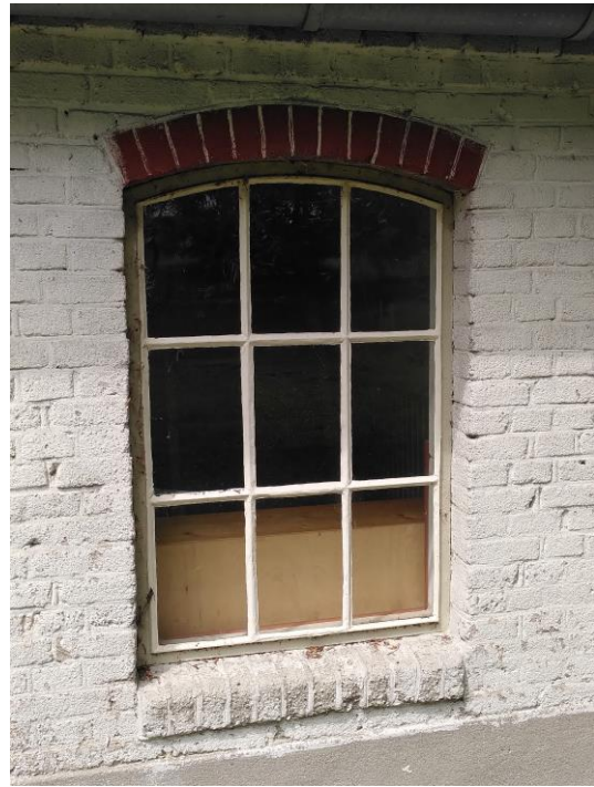
18. Venster in de oostgevel van de varkenstal.
