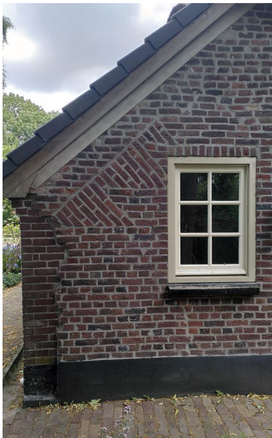
12. Kopgevel woongedeelte met bouwnaden uit de vierde bouwphase.
