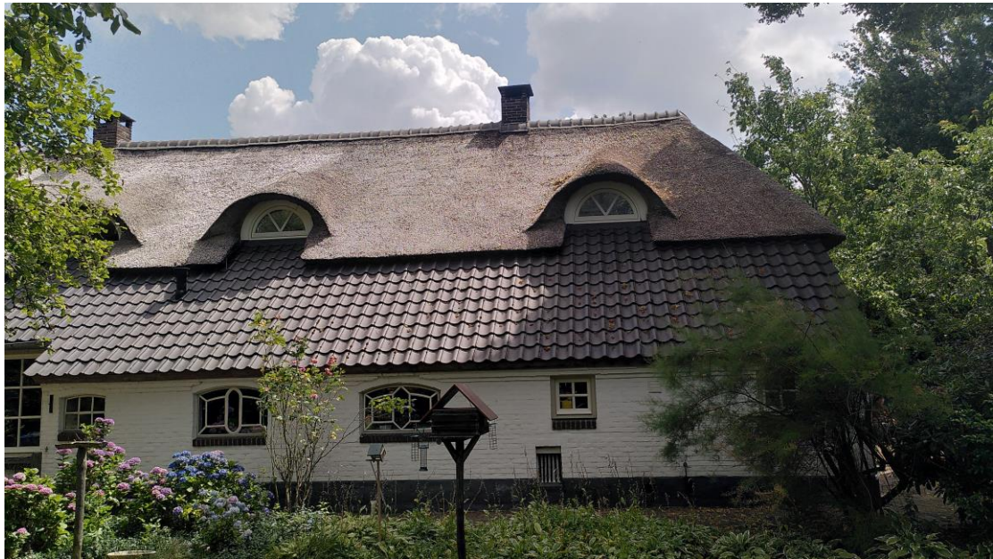
13. Lage gevel woon- en stalgedeelte.
