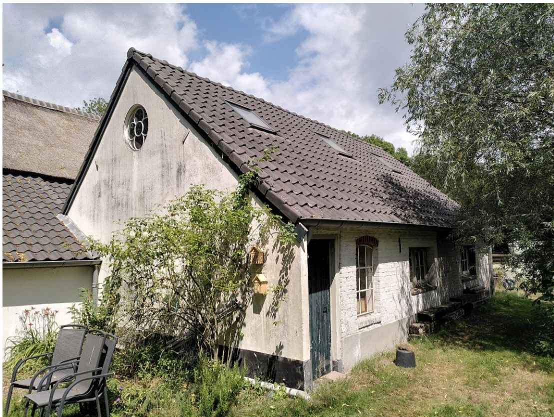
19. Voormalige varkenstal zuidoostzijde.
