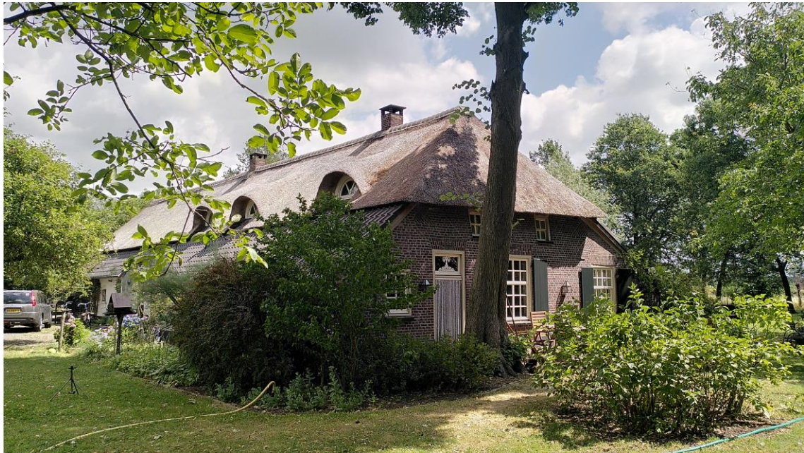
1. Woongedeelte aan de zuidzijde van de boerderij.
