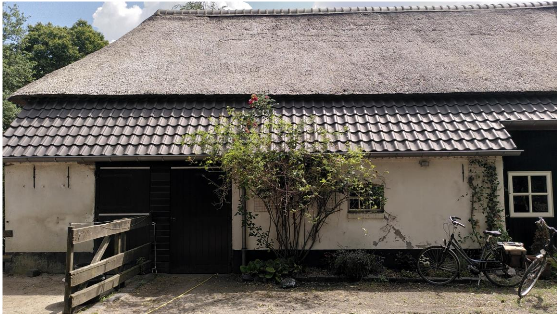
15. Gevel van het schuurgedeelte.
