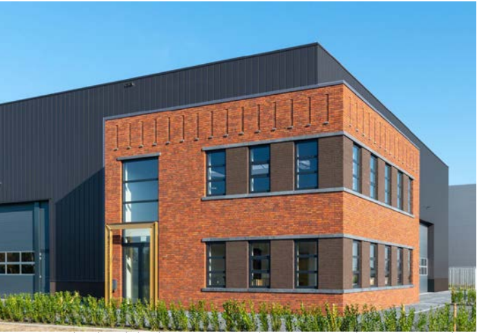
Materiaalgebruik baksteen in combinatie met plaatmateriaal
