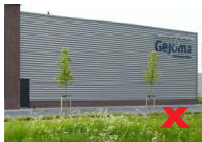
Geen dichte gevel aan Peelweg
