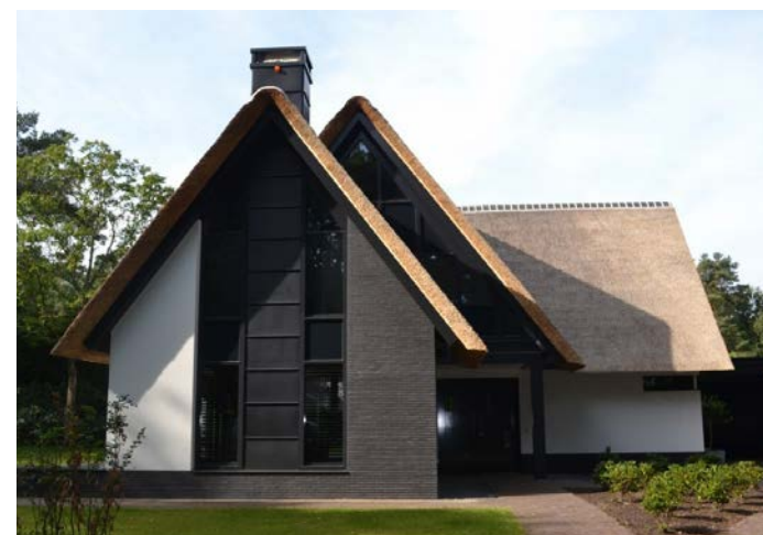
Samengesteld dak met rieten kap
