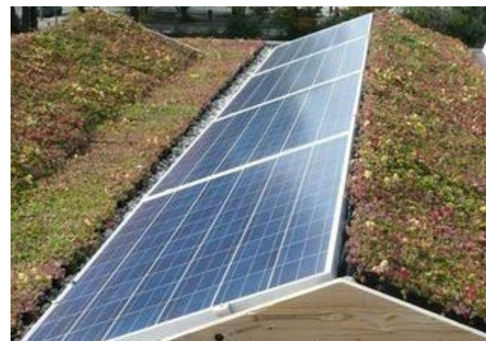
Zonnepanelen gecombineerd met sedumdak
