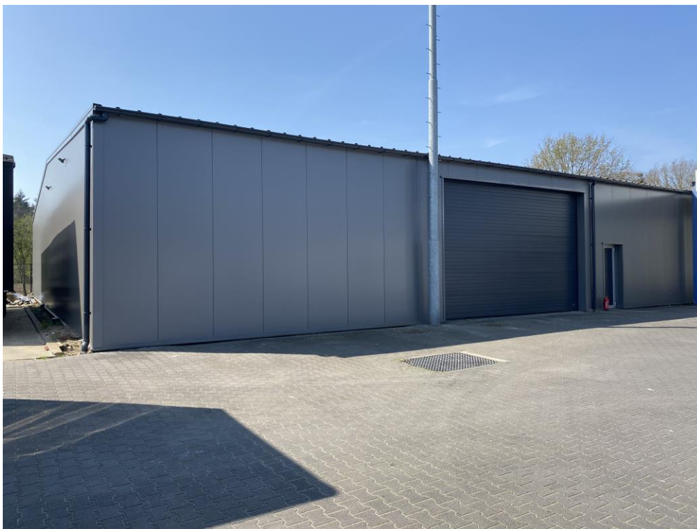
Voorzijde gebouw B
