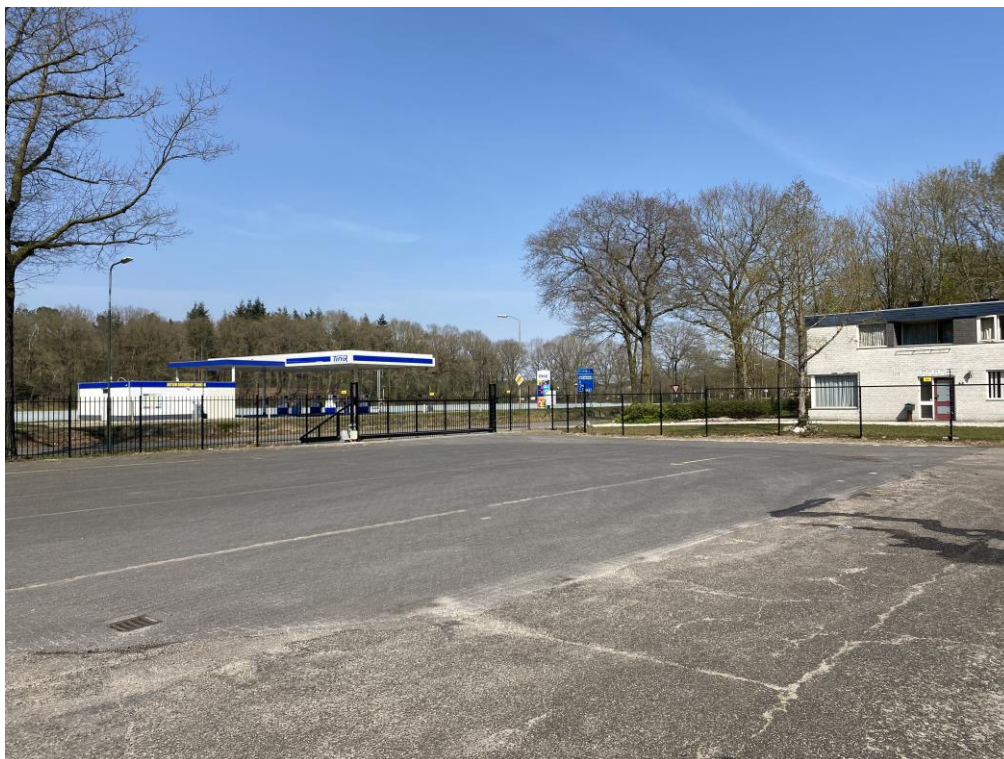
Parkeerterrein voorzijde richting het noorden
