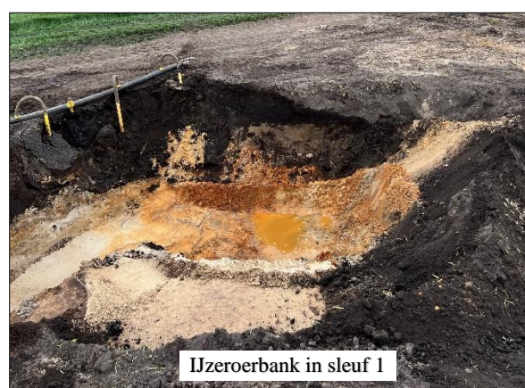
Figuur 2 Links: aanvang graafwerkzaamheden 4 sleuven Repelakker III op maandagochtend 25 april 2022 en rechts: opvallende ijzeroerbank in sleuf 1 (B) omringd door bemalingsfilters tot 4,5 m-mv.
