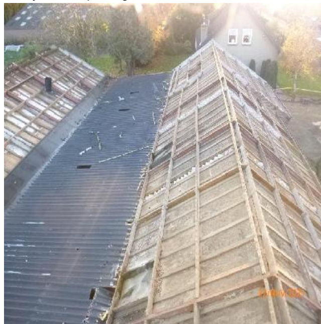
Verwijderde toepassing met asbestvrij dak,
