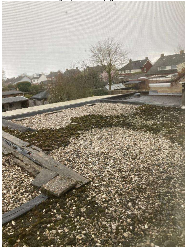
• Afbeelding 5: platdak bedrijfsgebouw
