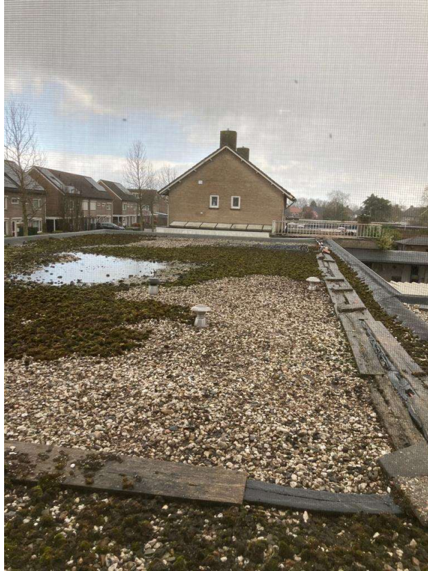
• Afbeelding 4: platdak bedrijfsgebouw
