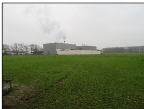
Foto 5. Plangebied gezien vanuit het noordoosten
