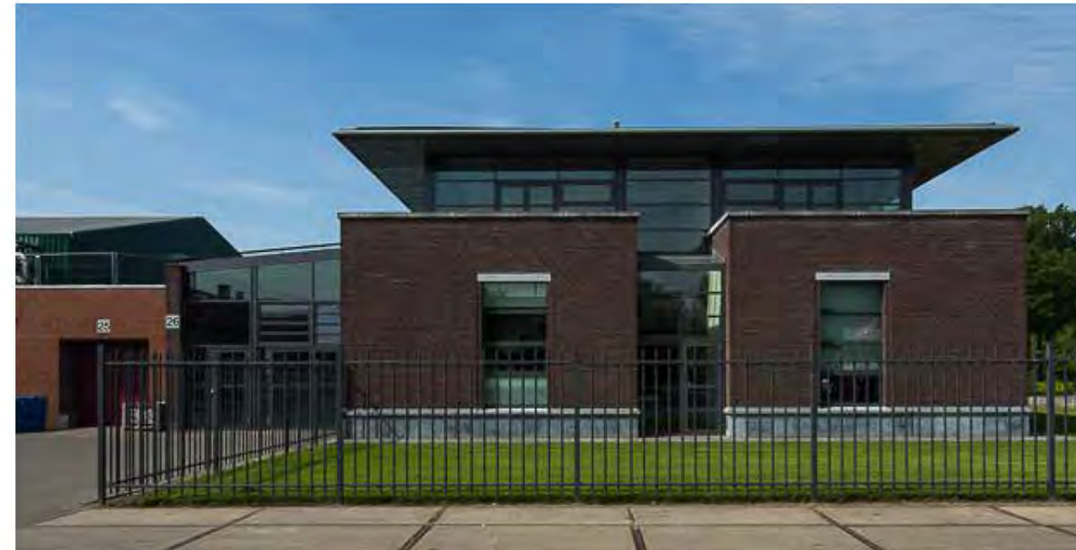
bestaand representatief hekwerk bij kantoorgebouw
