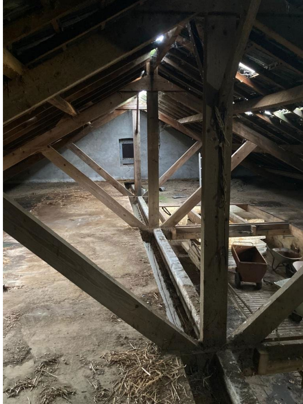
• Afbeelding 12: zolder te slopen stal
