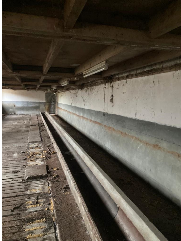
• Afbeelding 6: binnenzijde te slopen stal
