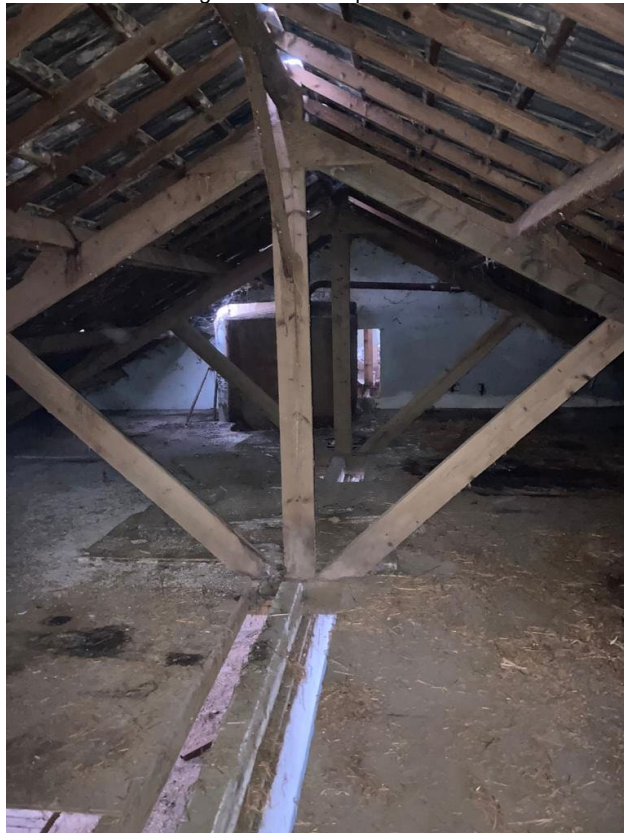
• Afbeelding 13: zolder te slopen stal
