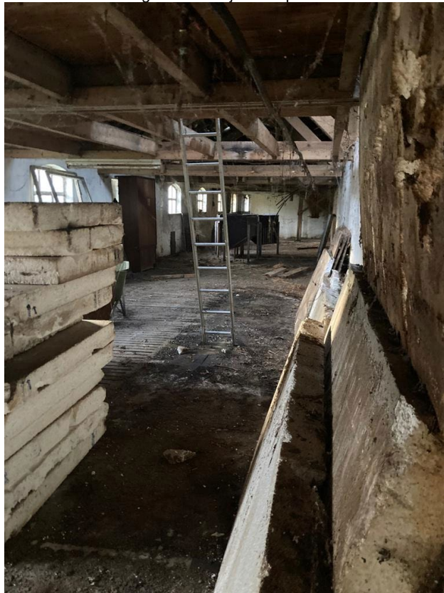
• Afbeelding 11: binnenzijde te slopen stal
