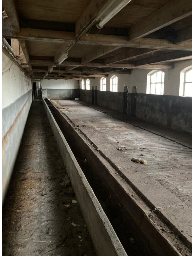
• Afbeelding 10: binnenzijde te slopen stal
