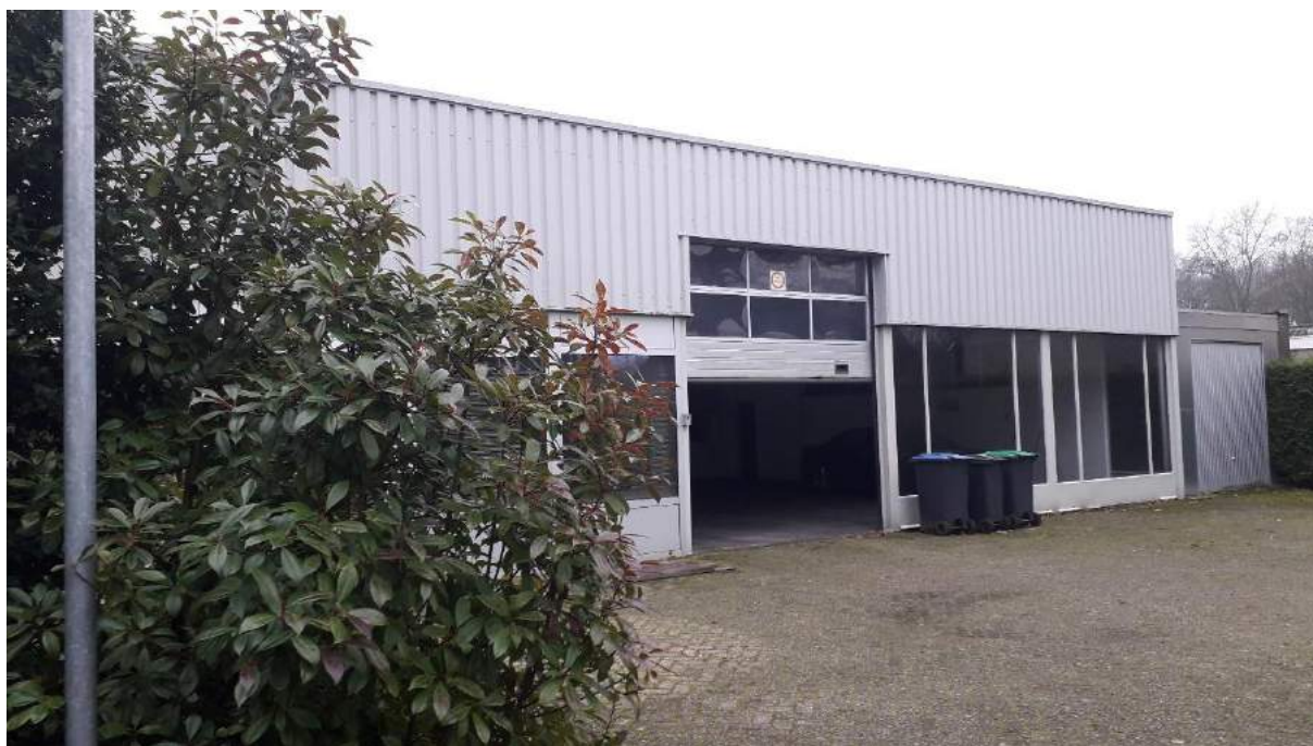
De zuidelijke garagehal achter het hoofdgebouw. De garages bestaan vrijwel geheel uit damwandplaten
