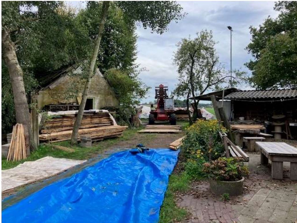
• Afbeelding 17: Erf met veel opslag van eikenhout tbv de bouwwerkzaamheden
