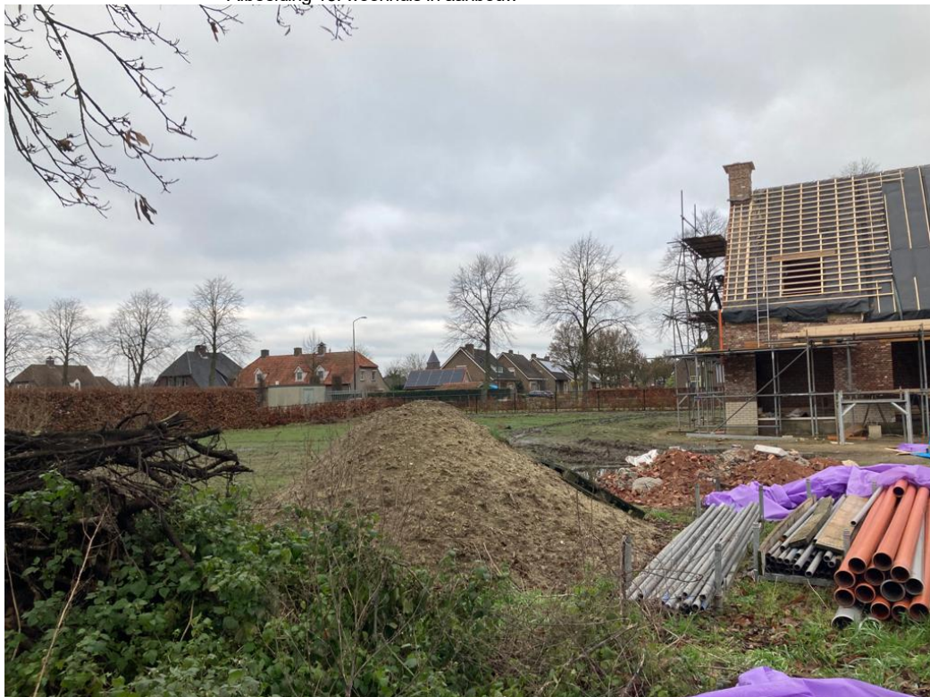
• Afbeelding 15: woonhuis in aanbouw
