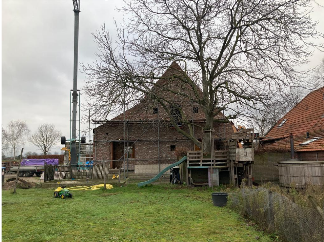
• Afbeelding 8: woonhuis in aanbouw
