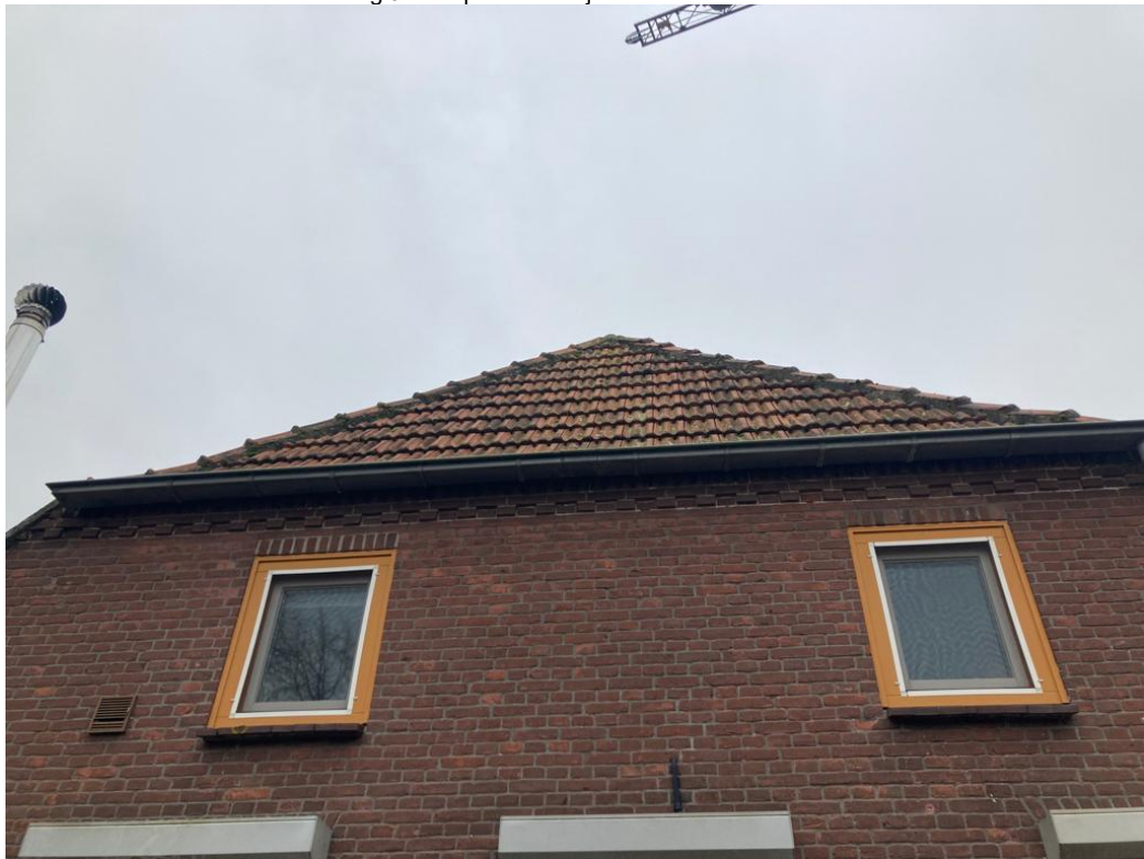
• Afbeelding 3: te slopen boerderij
