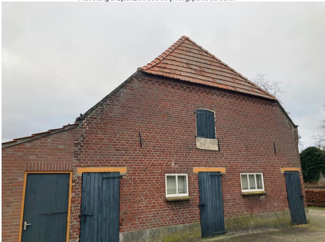
• Afbeelding 9: zij aanzicht boerderij met gepurde scheuren
