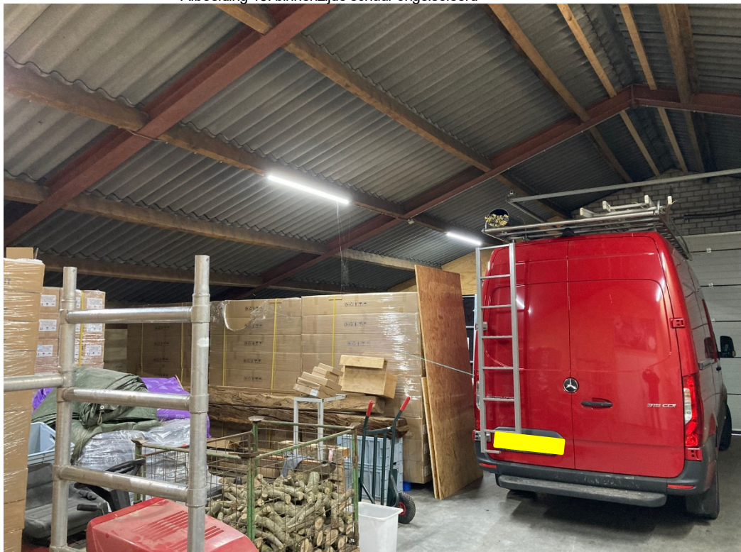
• Afbeelding 19: binnenzijde schuur ongeïsoleerd
