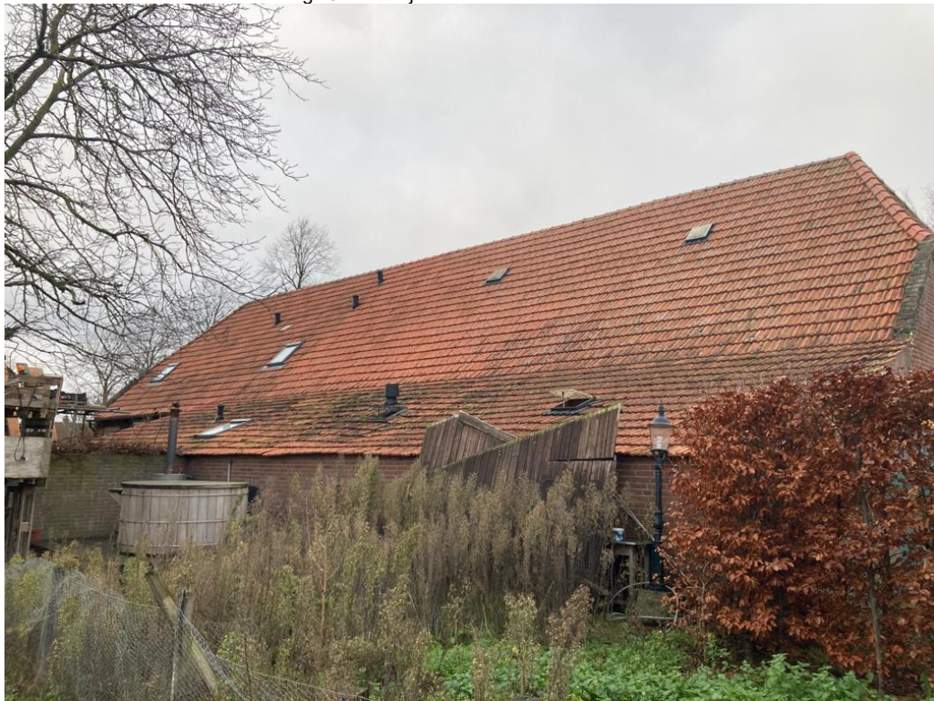
• Afbeelding 16: achterzijde woonhuis
