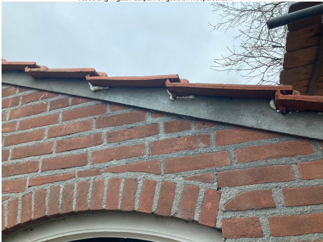
• Afbeelding 7: gaten dakpannen gesloten met purschuim
