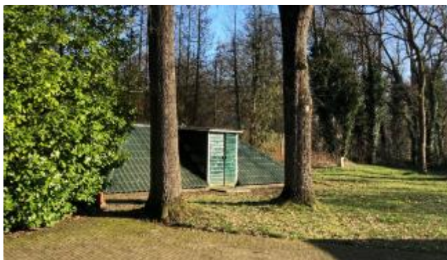
Figuur 2.1: Huidige bebouwing plangebied
