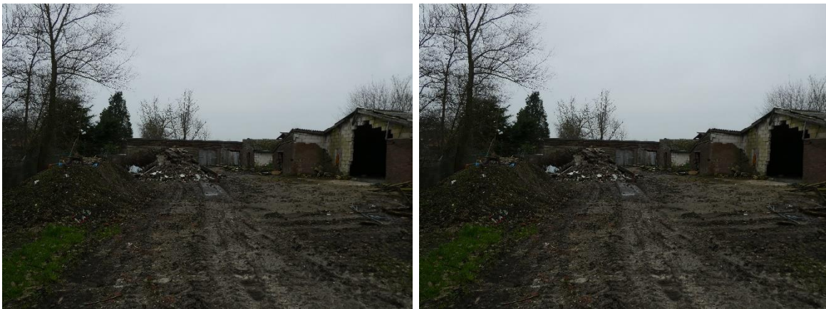
Afbeelding 3 en 4: Bestaande te slopen voormalige varkensstallen. Bron: BNL advies. Datum: 24-01-2023
