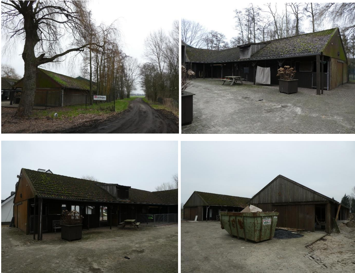
Afbeelding 5 t/m 8: Bestaande te slopen voormalige paardenstallen. Bron: BNL advies. Datum: 24-01-2023
