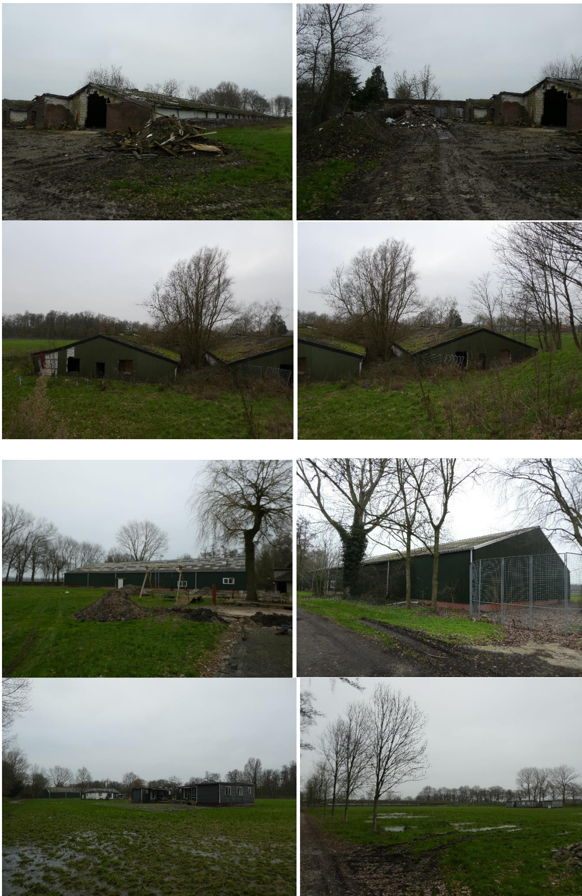
Afbeelding 3 t/m 14: Bestaande te slopen bebouwingen. Bron: BNL advies. Datum: 24-01-2023
