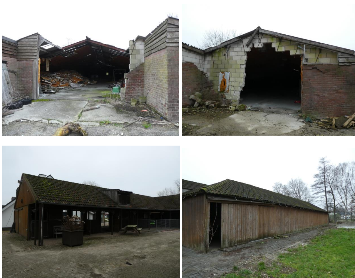
Afbeelding 19 t/m 22: de te slopen bebouwingen met mogelijke vaste rust- en verblijfplaatsen van vleermuizen. Bron: BNL advies. Datum: 24-01-2022
