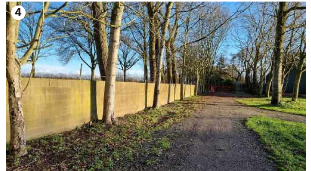
Zicht op de muur als geluidswal
