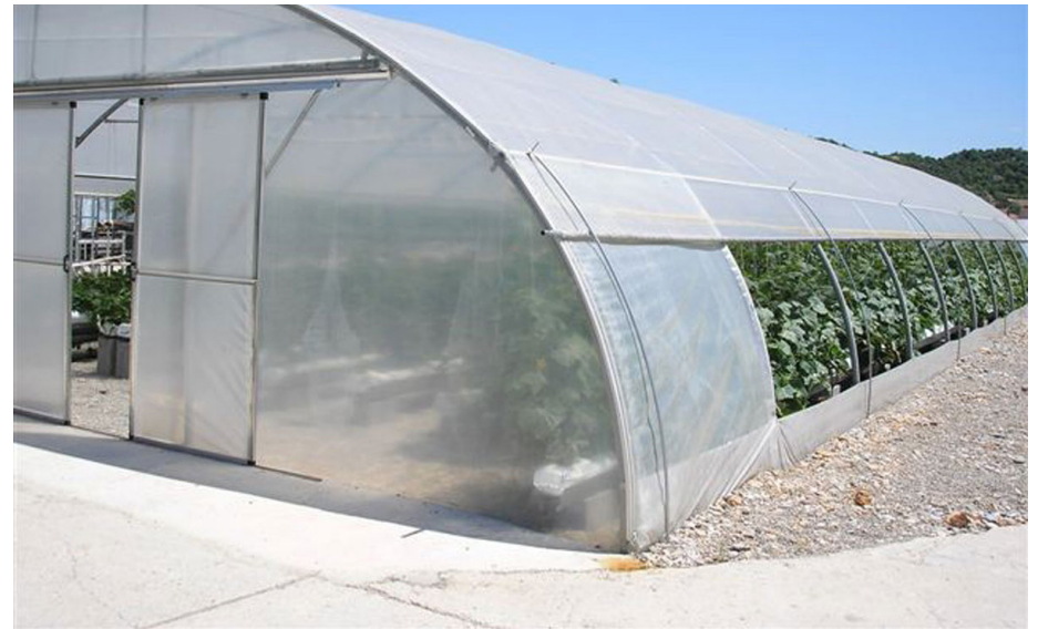
Tunnelkas met ronde zijwand (schapenstal met beplanting)
