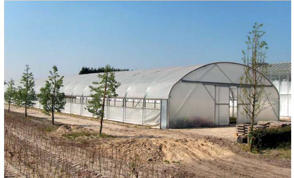
Tunnelkas met rechte zijwand (melkveeststal met tuinbouw in zomer)
