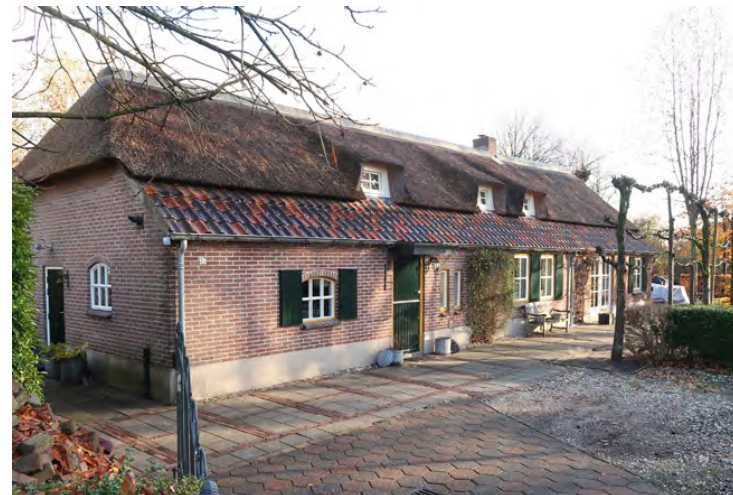
Van oudsher aanwezige langgevelboerderij - Nieuwstraat 37
