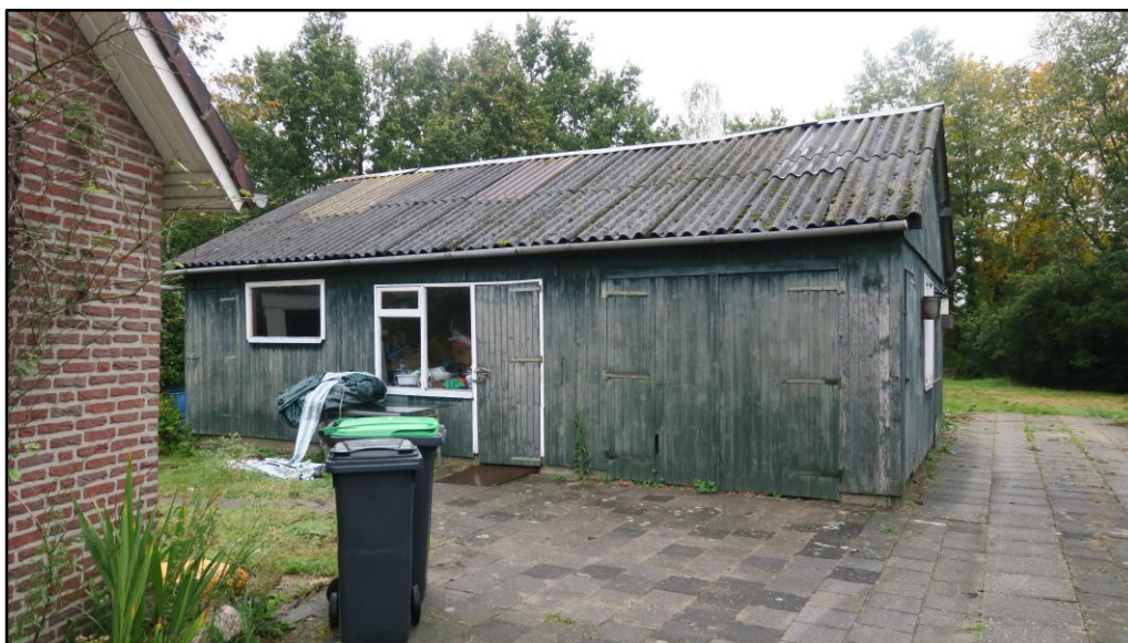
Figuur 2 De huidige schuur die gesaneerd zal worden.
