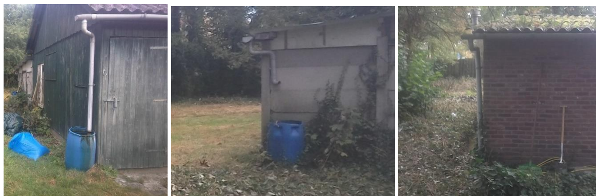
Foto's: locatie regentonnen regenpijp
