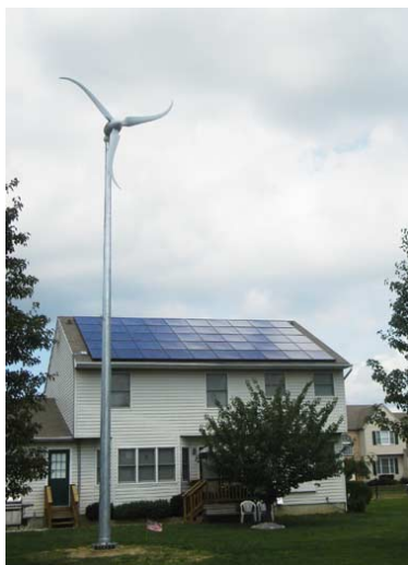
Figuur 54. Kleinschalige windmolen: type Skystream
