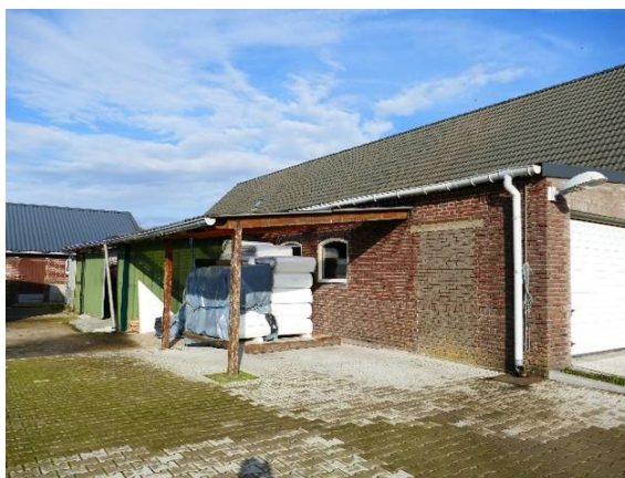
Achtergevel stalgedeelte met aanbouw
