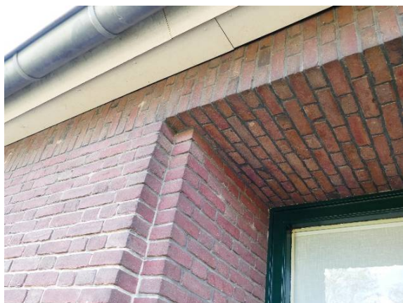
Metselwerk in nis voordeur en gevelbeëindiging.
