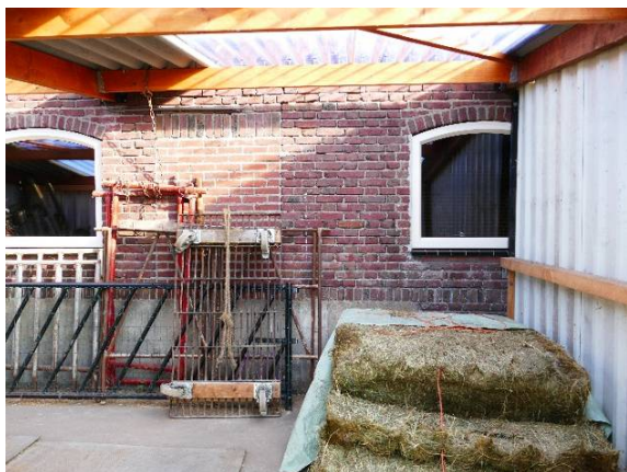
Achtergevel stal met twee stalramen en dichtgezette loopdeur.
