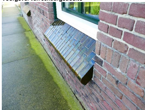
De vensters van het woongedeelte hebben een robuuste lekdoorpel van geflazuurde stenen
