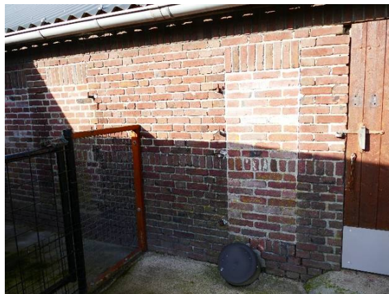
Dichtgezette dubbele varkensdeurtjes in de lange gevel aan de zuidzijde.
