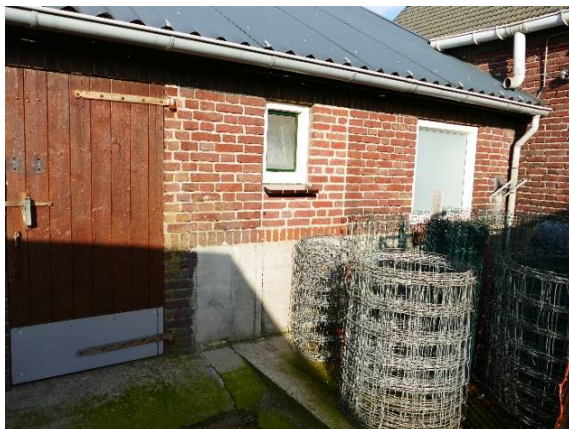
Ook in de gevel aan de zuidzijde zijn later deuren verplaatst en ramen toegevoegd.
