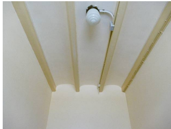
In de gang is het balkenplafond nog zichtbaar. Het is een chic plafond met gestucte trogjes.
