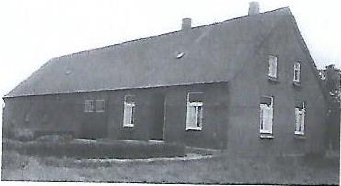
Boerderij in de nog originele staat. Woongedeelte en schuur liggen tegen de voorgevel. Het dak heeft asbest leien en twee schoorstenen. Het schuurgedeelte heeft deeldeuren in de voorgevel (hooi) en eindgevel (koren).
