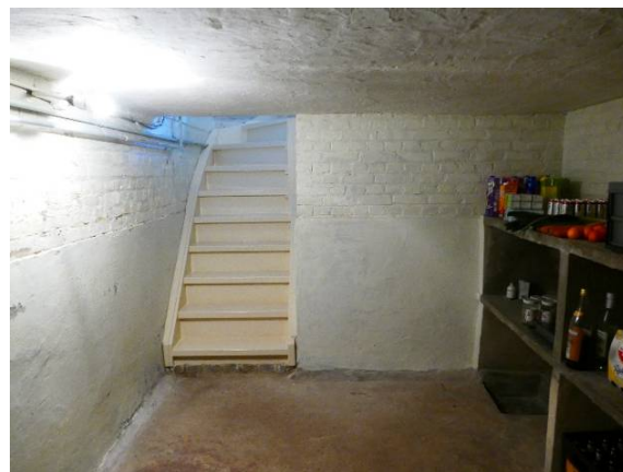
De kelder met vlak stenen plafond ligt helemaal onder het maaiveld.
