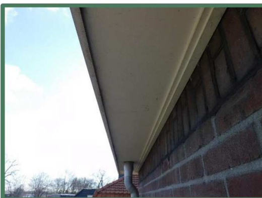
Afbeelding 27: gootbetimmering aansluitend op muur
