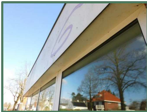
Afbeelding 24: Tresa boeiboorden met kunststof kozijnen
