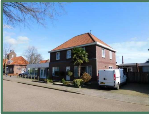
Afbeelding 10: Bedrijfswoning vanaf het zuidwesten
