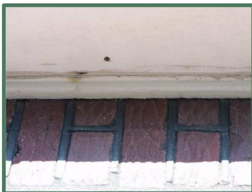
Afbeelding 26: gootbetimmering aansluitend op muur
