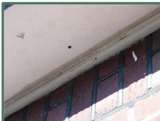
Afbeelding 22: gootbetimmering aansluitend op muur
