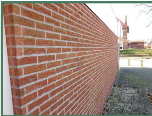
Afbeelding 12: Zijgevel vanaf het noordoosten
