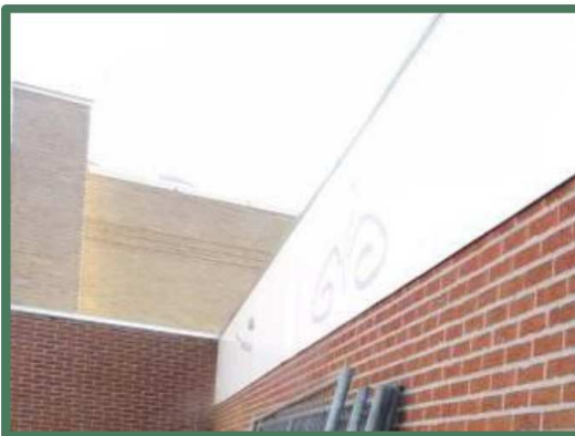
Afbeelding 25: Tresa boeiboord strak aan de wanden
