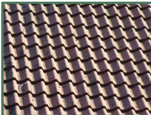
Afbeelding 21: Dakpannen strak aangesloten
