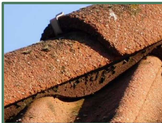
Afbeelding 20: Nokpannen geheel gesloten
