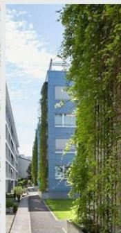
Verticale gevelbeplanting door raamwerk voor gebouw
