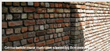
Gemetselde muur met ruwe stenen bij Boerenerven
