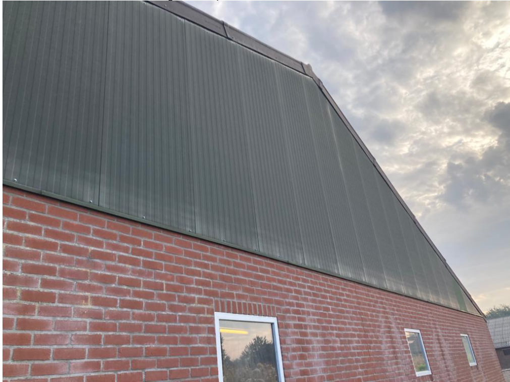
• Afbeelding 17: te slopen varkensstal
