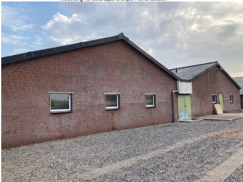
• Afbeelding 18: buitenzijde te slopen varkensstallen
