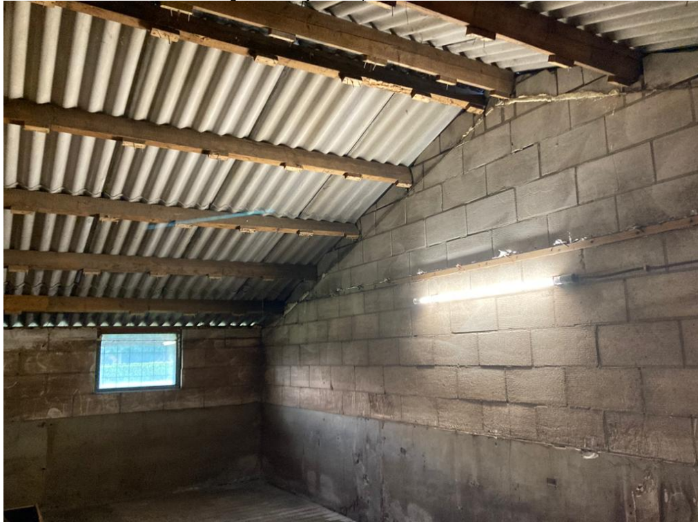
• Afbeelding 7: binnenzijde te slopen varkensstal
