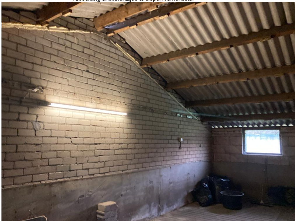
• Afbeelding 8: binnenzijde te slopen varkensstal
