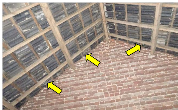
Figuur 5.4 Ruimte tussen dak en gevel.
