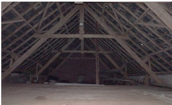
Figuur 5.5 Dakconstructie geschikt als hangplek voor de gewone grootoorvleermuis.
