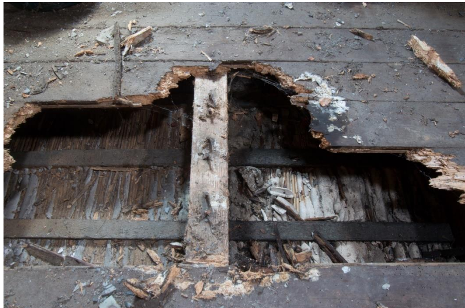
De houten balklaag boven de keuken, tevens zicht boven op het stucplafond dat in de keuken aan het zicht onttrokken is.
