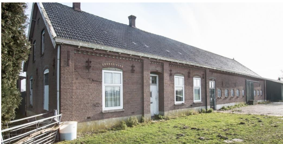
De voorgevel van het pand. Geen van de vensters dateert nog uit de bouwtijd. Deurpartijen zijn deels oorspronkelijk.
