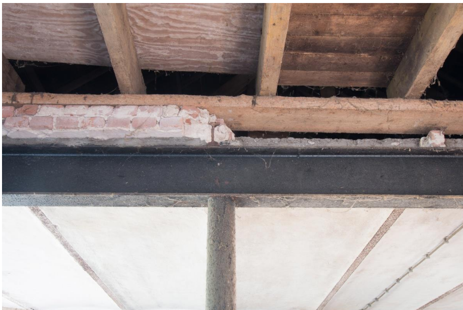
De overgang van de vloerconstructie in de stal. De stalen balk moet in plaats zijn gekomen van een gesloopte dwarsmuur. Beide vloerconstructies dateren vermoedelijk uit de bouwtijd.
