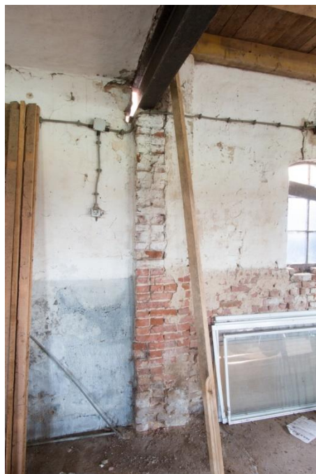
Nogmaals de overgang van de zoldervloerconstructies, met zicht op afgehaakt metselwerk, een ingewerkte stalen balk en rechts een stalen venster in de achtergevel.
