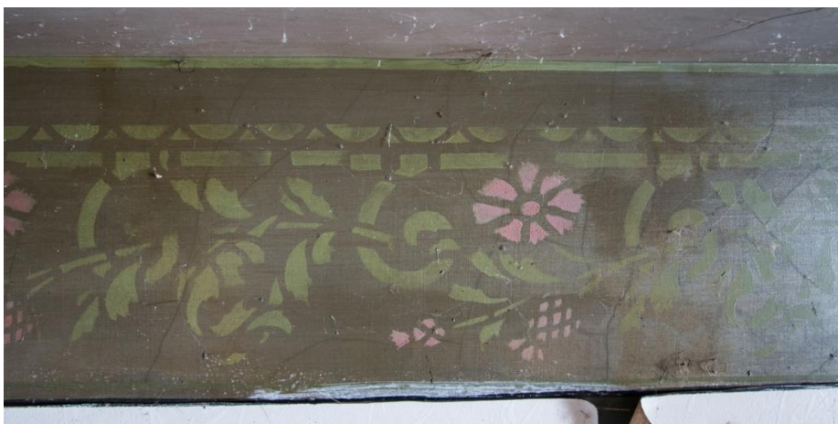
Lijstwerk met sjabloonschildering aansluitend op het stucplafond.
