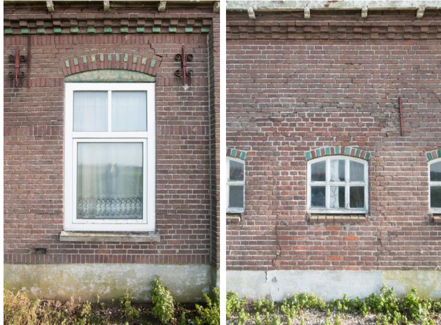
De gevelarchitectuur van het woongedeelte (met vernieuwd venster) en het stalgedeelte, met een secundair stalraam in een dichtgezette deuropening.
