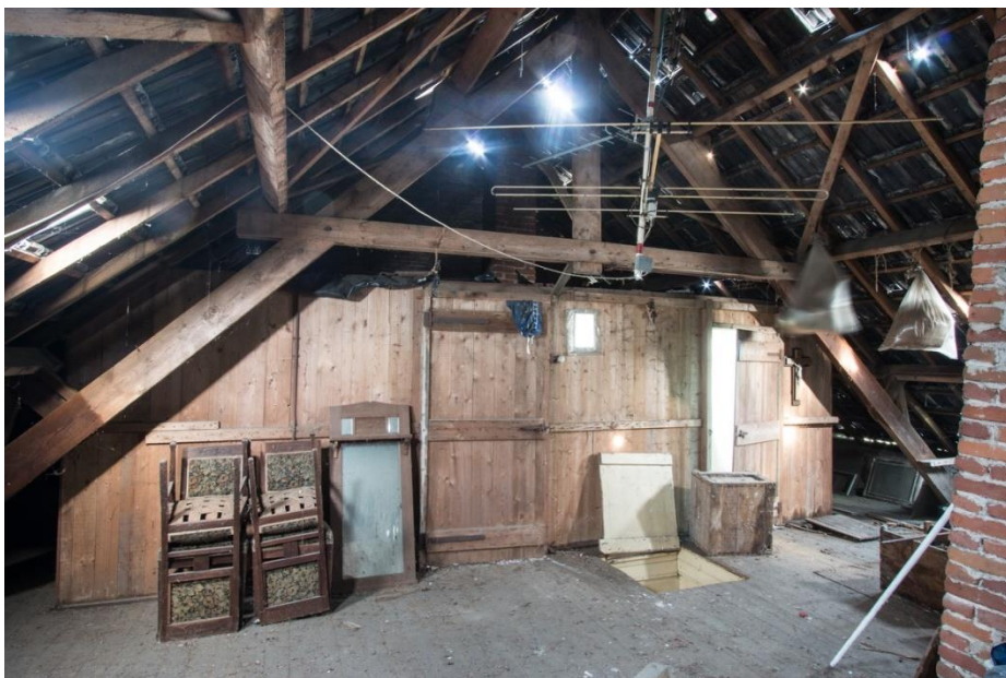
De kapconstructie boven het woongedeelte, met zicht op de wand van de slaapkamers.
