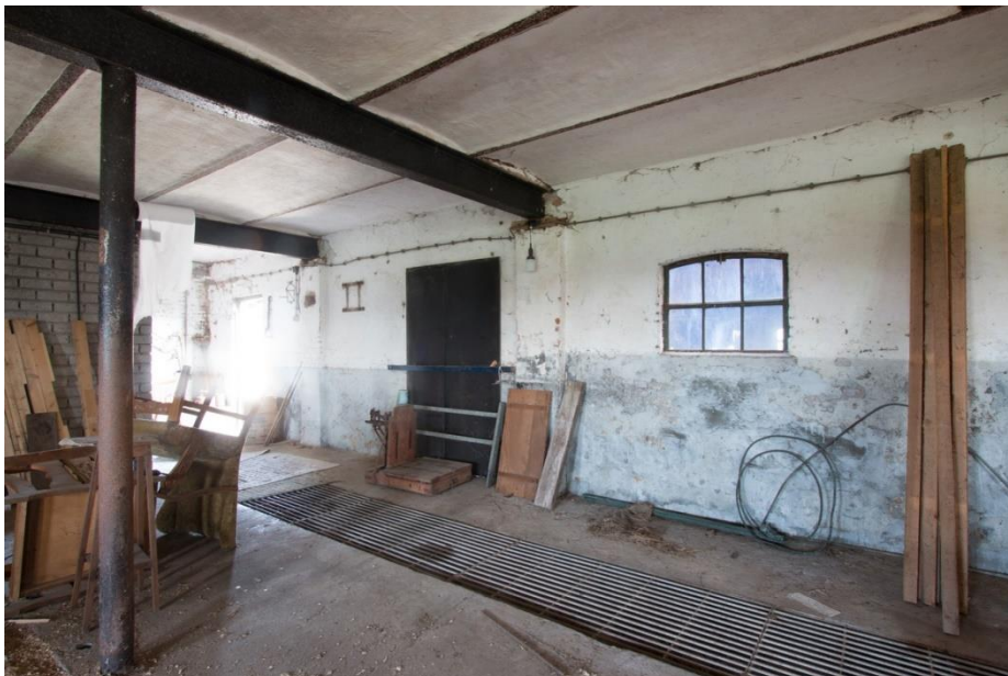
De achtergevel van het stalgedeelte met vernieuwde staldeer en een nog uit de bouwtijd daterend ijzeren stalraam.
