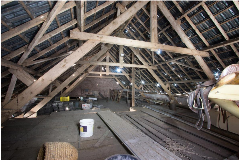
De kapconstructie boven het bedrijfsgedeelte.
