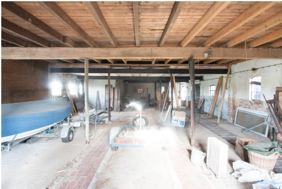
De houten vloerconstructie in het achterste deel van de stal. Stalen kolommen lijken latere toevoegingen omdat we ter plaatse in de balken pengaten zien.
