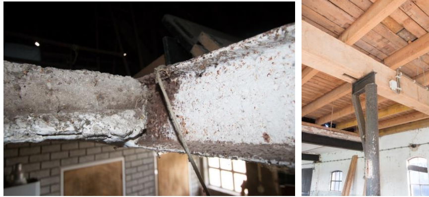
De aansluiting van het beton op de stalen vloerliggers. Rechts één van de genoemde pengaten.
