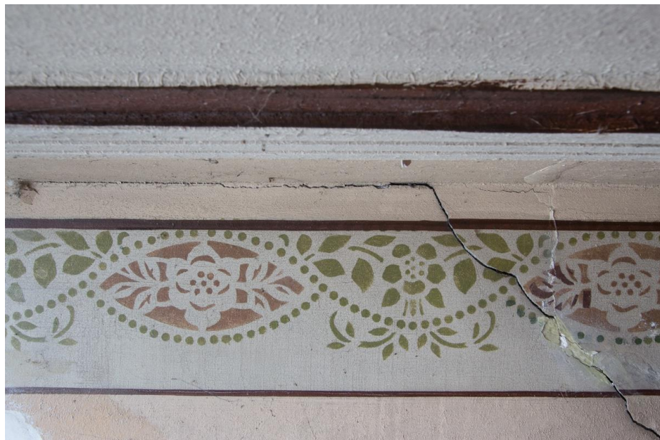
Lijstwerk op de gangmuren, aansluitend op het stucplafond.
