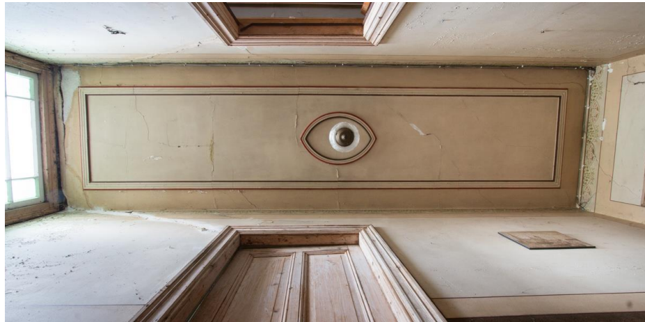
Het plafond in de gang.
