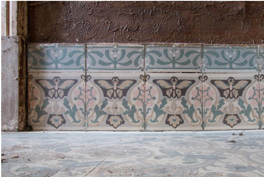
Tegelplint en cementwerk van de lambrisering in de gang.
