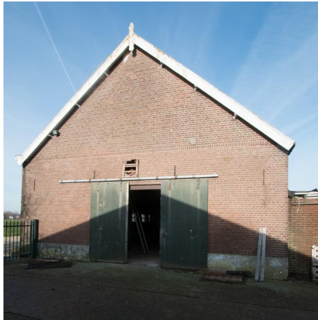
De rechter zijgevel met vermoedelijk een toegevoegde deuropening.
