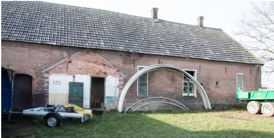
De achtergevel met aftekening van waar eens een aanbouw met bakhuis stond.
