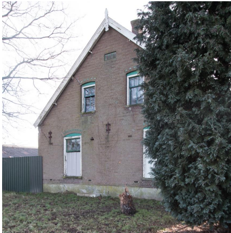
De kopgevel van het woongedeelte verkeert nog in oorspronkelijke staat, met dien verstande dat op de begane grond vensters niet meer compleet zijn.
