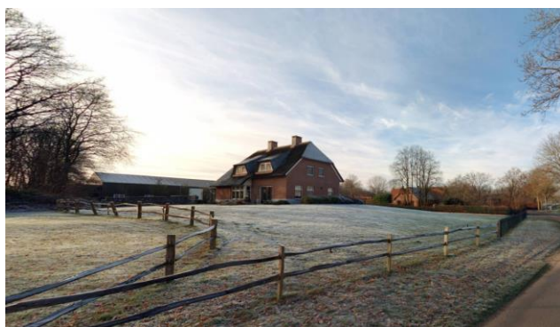
Foto: aanzicht bestaande boerderij
