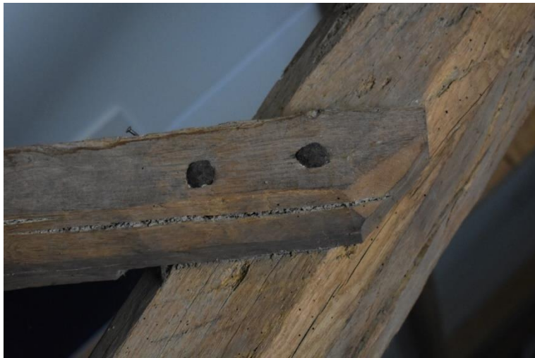
Gesmede spijkers in de dakconstructie boven bedrijfsgedeelte.
