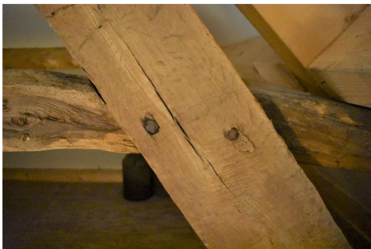
Gesmede spijkers in het A-spant.
