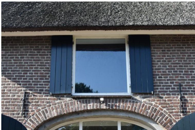
Nieuw venster in oorspronkelijke hooiluik opening.
