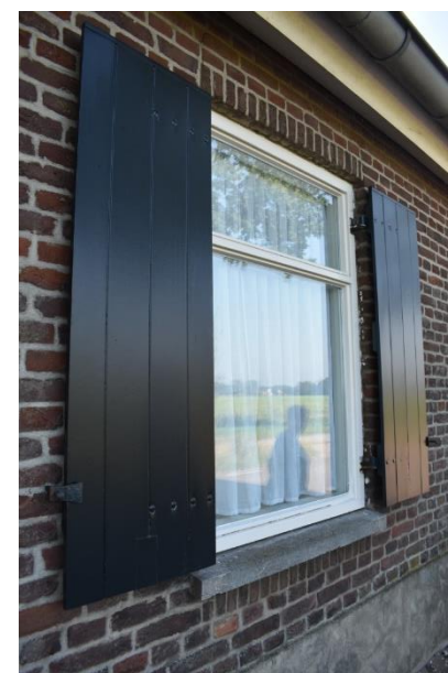
Oorspronkelijke gevelopening met vernieuwd venster.
