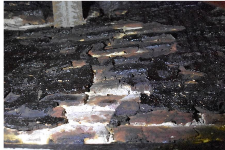
Metselwerk aan de binnenzijde van de schouw.
