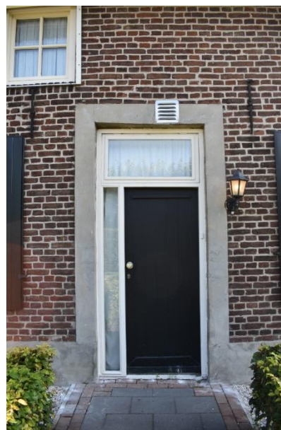
Voordeur in cement-omlijsting.
