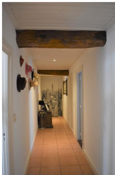
Een van de ankerbalken in het bedrijfsgeboude.
