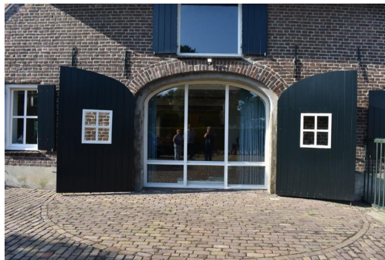
Nieuwe pui en vernieuwde deuren in oorspronkelijke opening.
