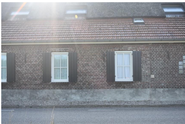
Houten vierruitsvensters ter vervanging van de stalvensters.
