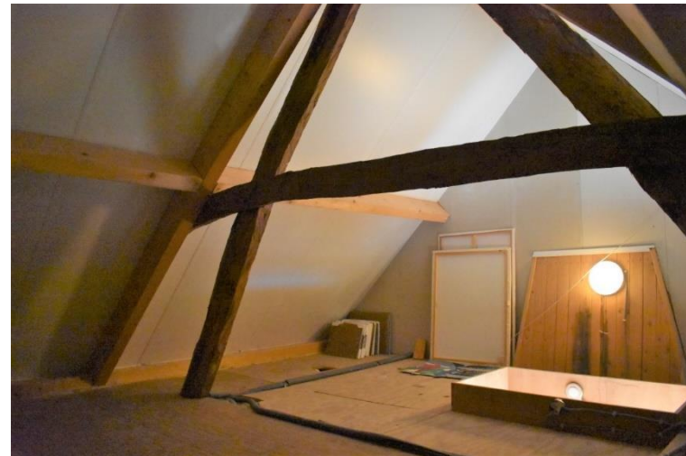
A-spant op zolder boven woongedeelte.
