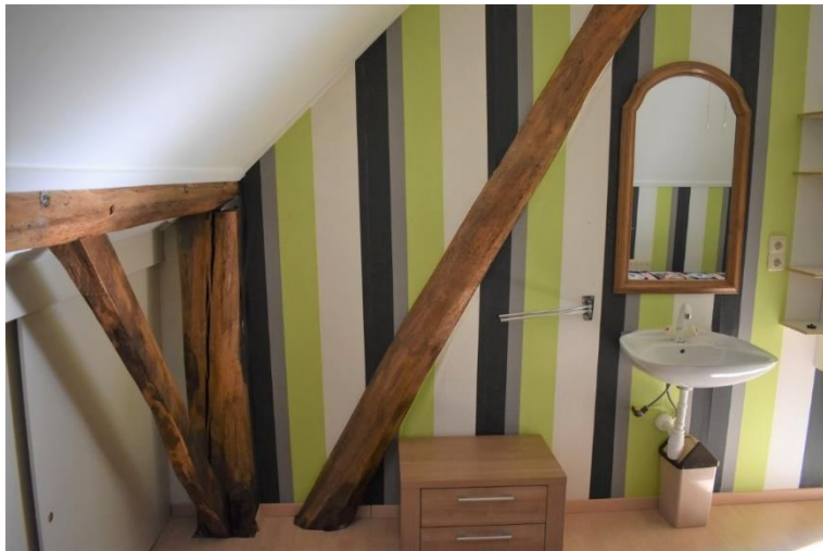
Gebintstijl en spant op de verdieping boven het woongedeelte.
