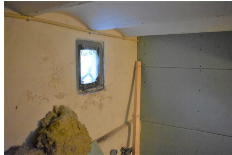
Kelder met oorspronkelijk plafond van troggewelven.
