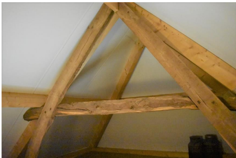
A-spant op zolder boven woongedeelte.
