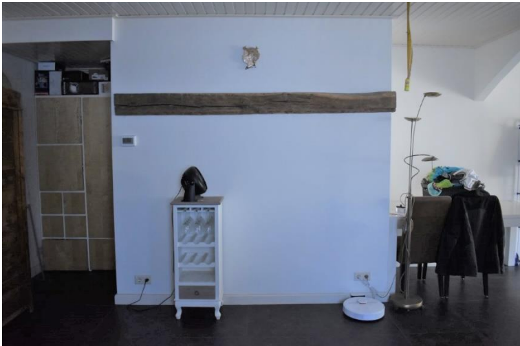
Dichtgezette schouw in het woongedeelte.
