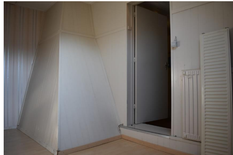
Oorspronkelijk rookkanaal op de verdieping.
