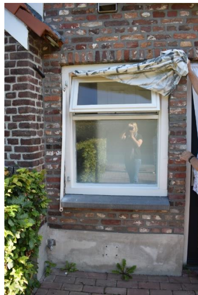
Hergebruikt gepend kozijn.
