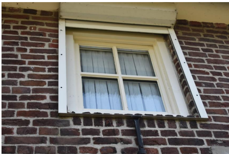
Vernieuwd venster op de verdieping van de voorgevel.
