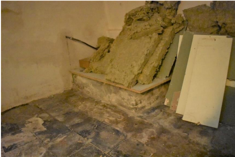
Rechts pekelbak en links afkoelkuil in kelder.
