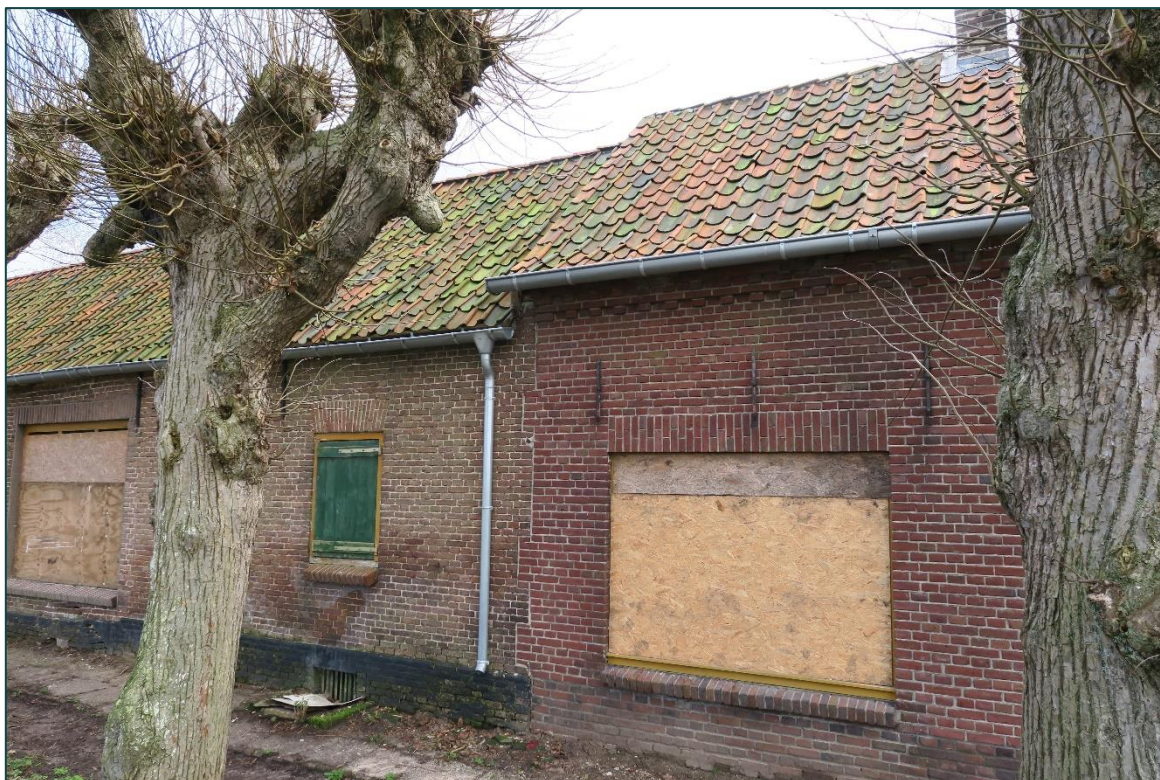
Figuur 2 De bebouwing bestaat uit enkelsteense muren en betreft een dak van dakpannen.
