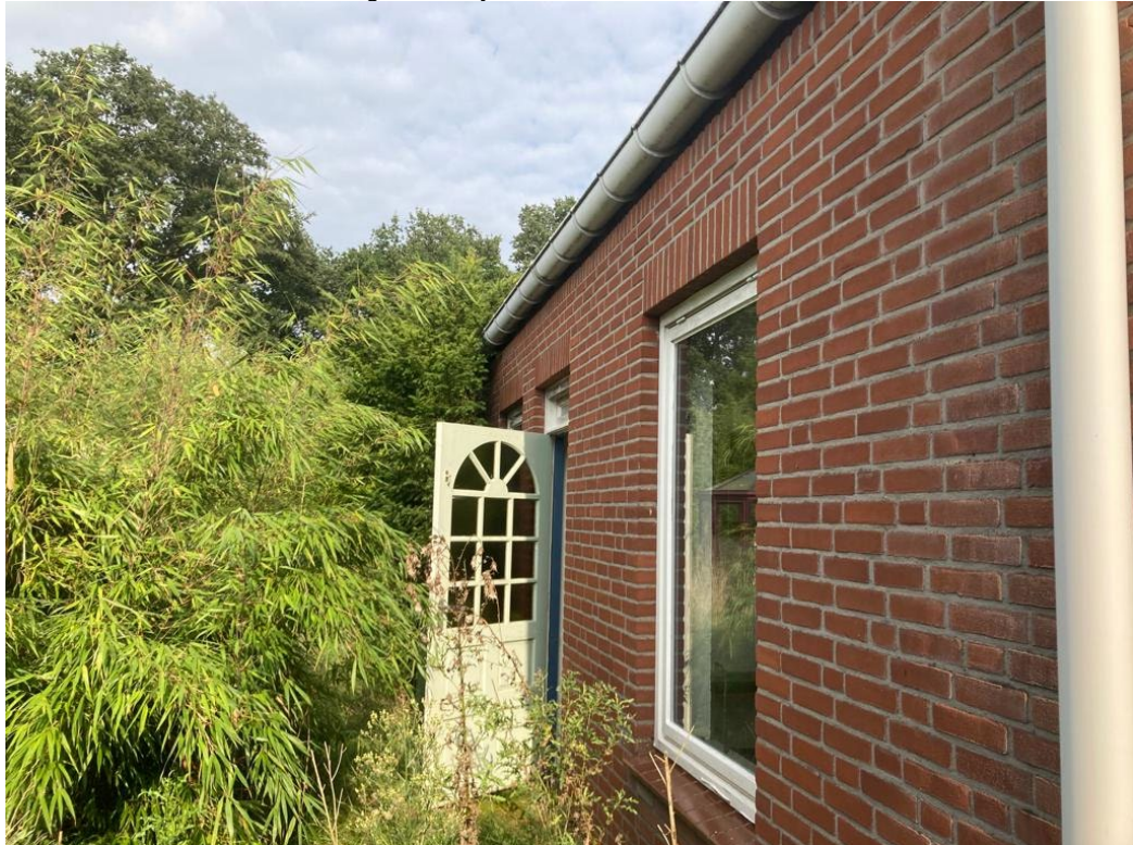
• Afbeelding 6: buitenzijde schuur met bamboe
