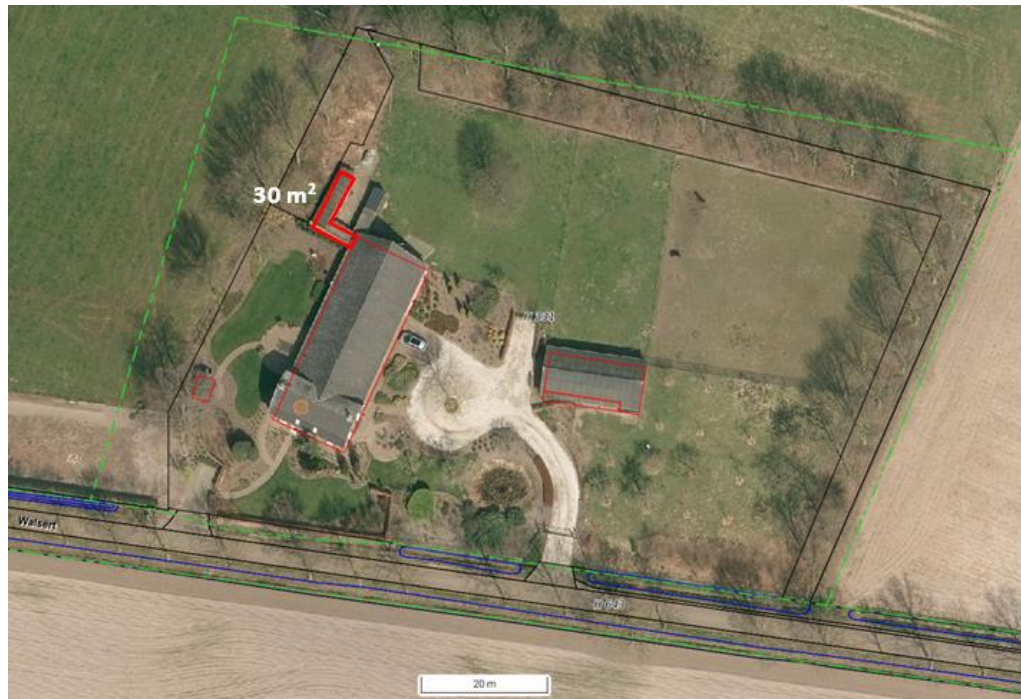
Figuur 1 Luchtfoto met bijbehorend bouwwerk vergunningsvrij bouwen van 30 m 2 rood omkaderd
