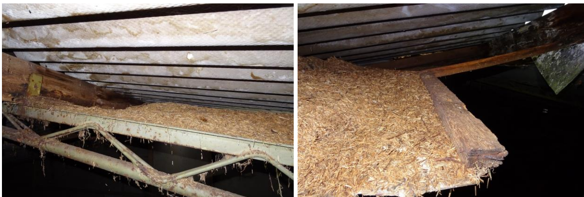
Afbeelding 5 en 6: openstaande isolatieplaten zijn gecontroleerd op sporen van de kerkuil. Deze zijn niet aangetroffen.
