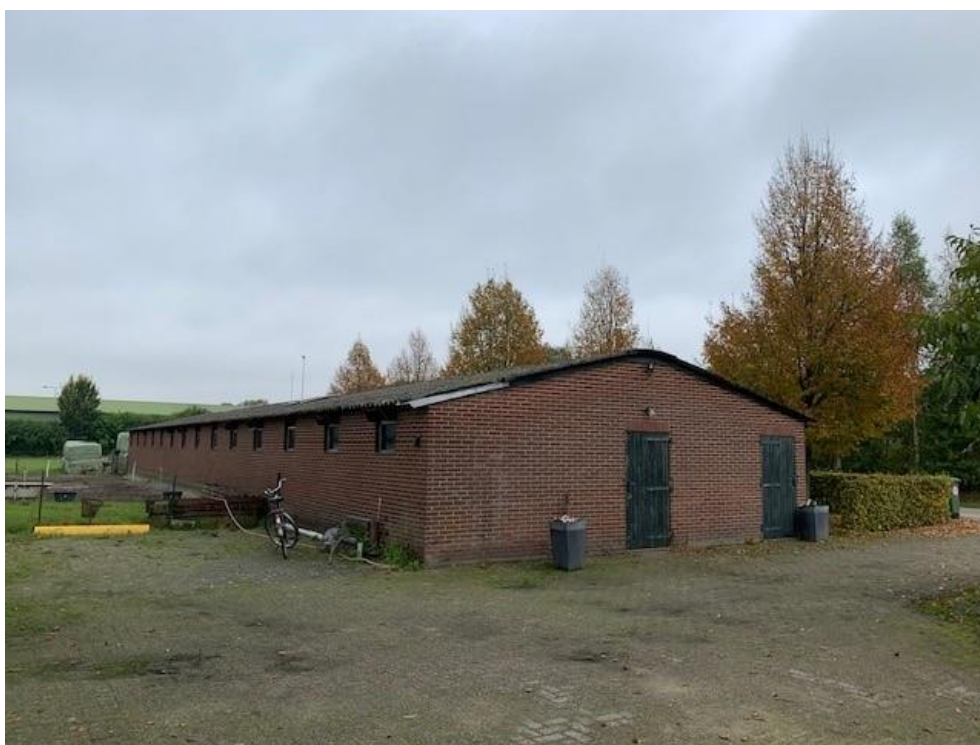
Deels te slopen opstal ten noordwesten van de woonboerderij
