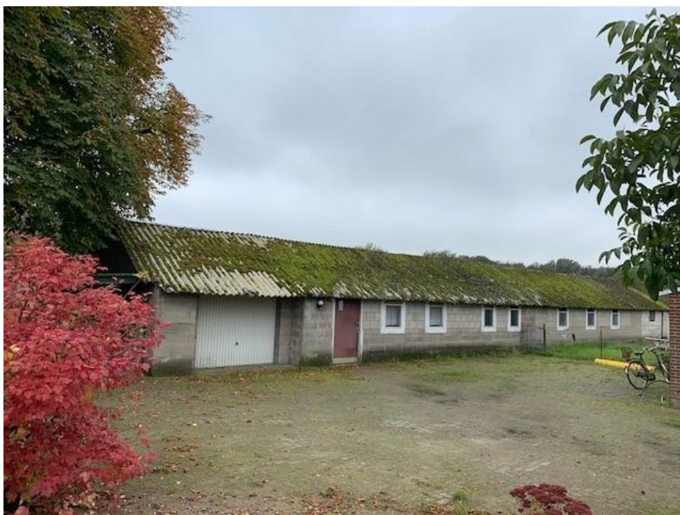
Te slopen voormalige varkensstal ten noordwesten van de woonboerderij
