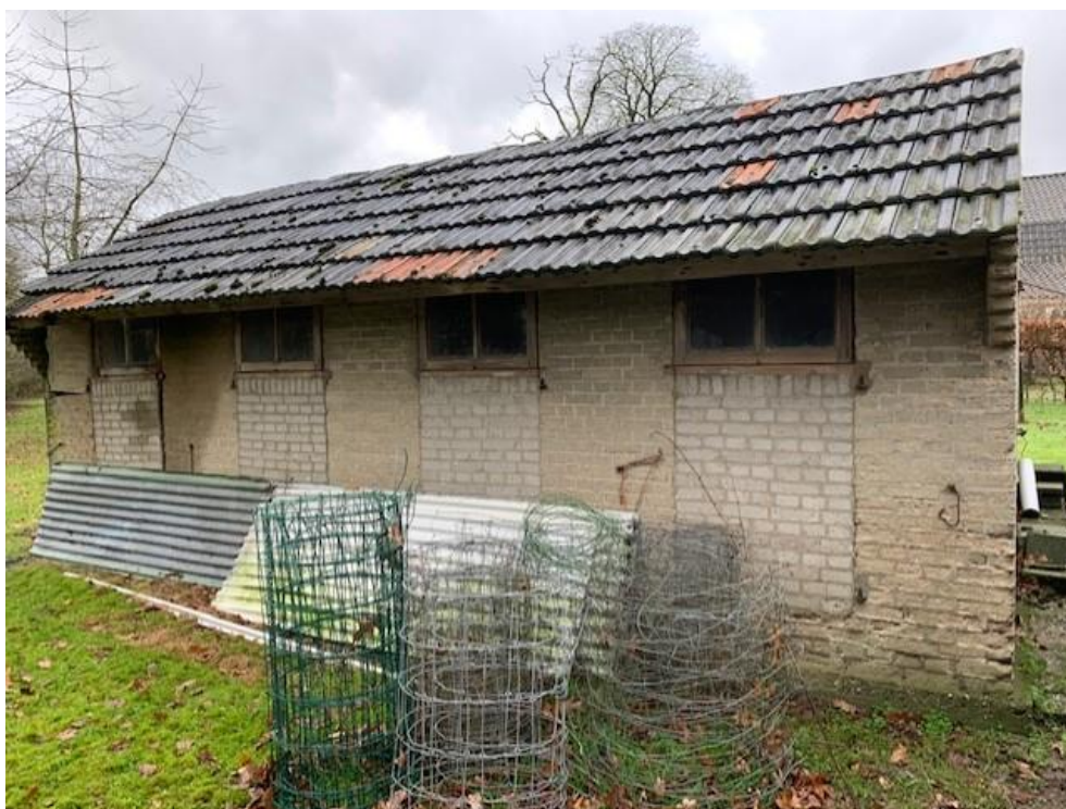
Zuidoost georiënteerde gevel kippenschuur
