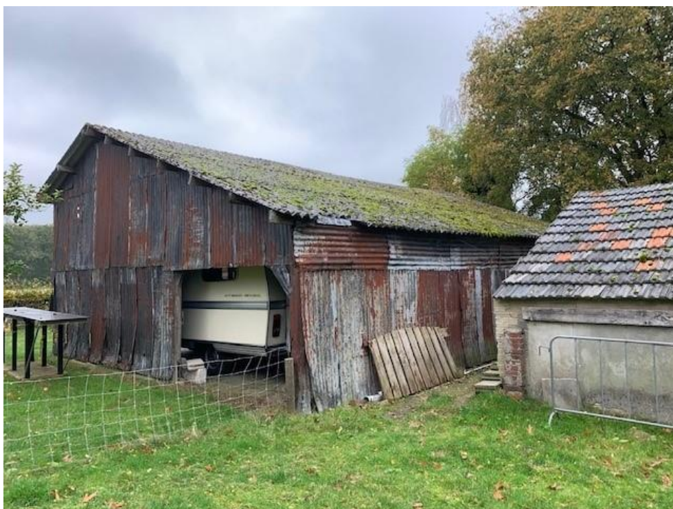
Links de te slopen overkapping en rechts een voormalige kippenschuur (ten zuidoosten van de woonboerderij)
