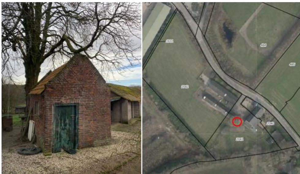
Het te renoveren en te behouden bakhuisje (ten westen van de woonboerderij)
