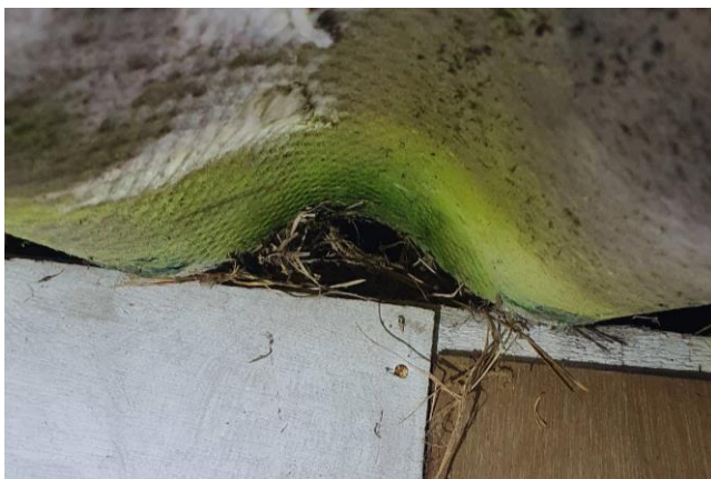
Figuur 4.4.1. Onder de golfplaten is geen vogelschroot aanwezig. Bij zowel de noordelijke als zuidelijke schuur is op meerdere plekken onder de golfplaten nestmateriaal aanwezig.
