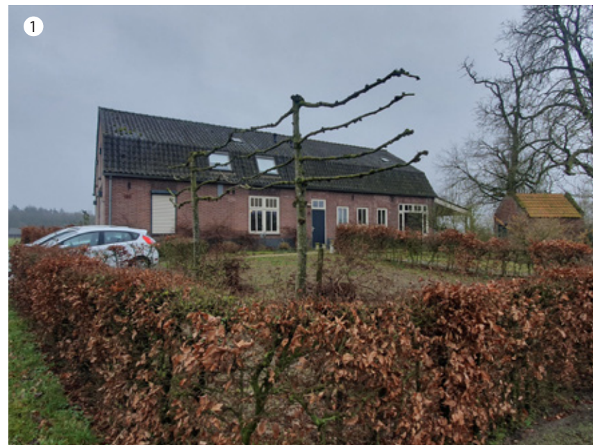
Zicht vanaf de oprit van de woning en bakhuisje
