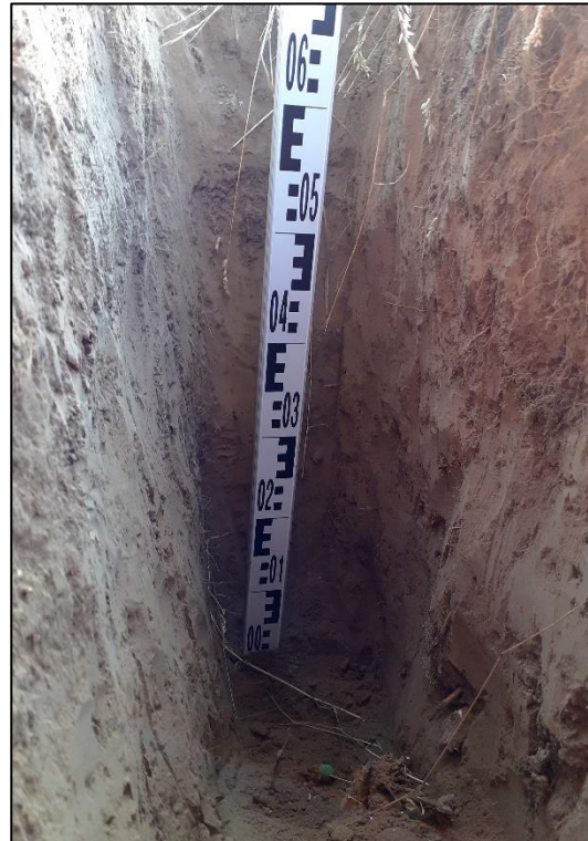
Afbeelding 6: Profielkuil op 4,0 meter van de erfsgrens
