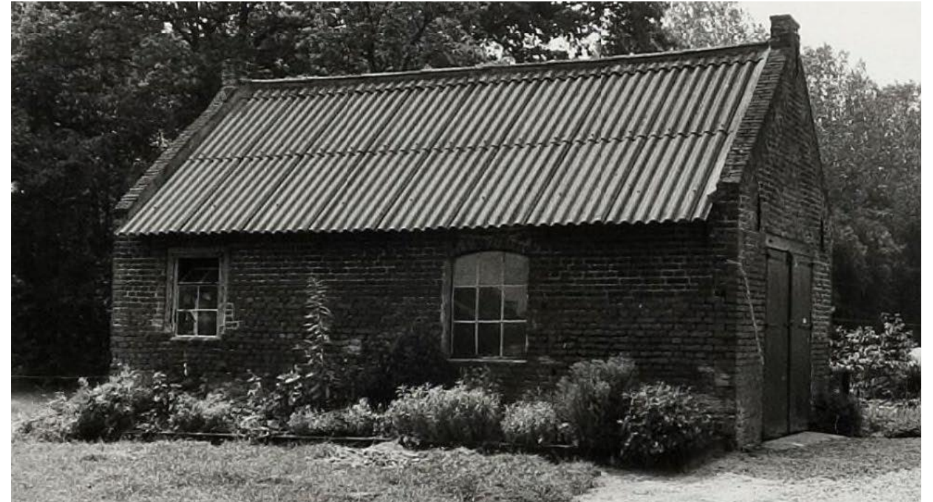
Afb 13: Het bakhuis gefotografeerd in 1986. In de kopgevel is nog een houten deurstel te zien. (auteur: Wies van Leeuwen)
