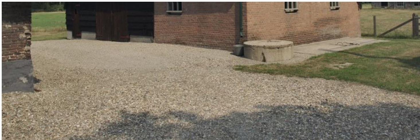
Afb 27: Halverharding als grind en handvorm klinkers
