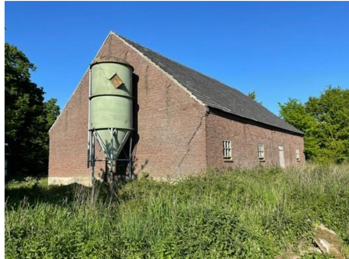
Afb 16: De landbouwschuur vanuit het westen gezien met silo op de voorgrond.
