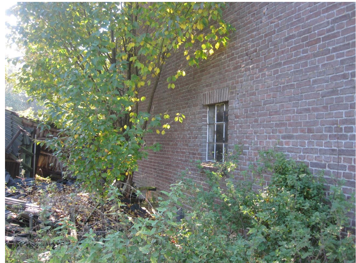
Afb 17: De oostelijke kopgevel van de landbouwschuur met op de voorgrond de restanten van de kippenschuur.
