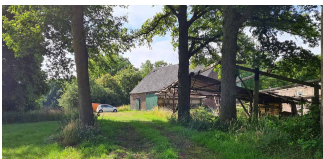
Figuur 13: Zicht op de te slopen stallen/loodsen met op de achtergrond de te slopen landbouwschuur.
