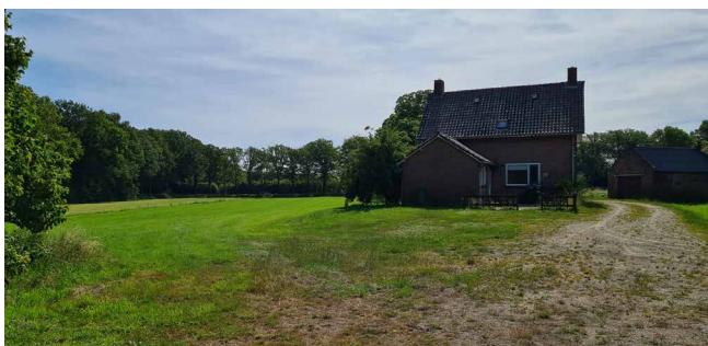
Figuur 12: De reeds aanwezige bedrijfswoning gelegen op een terp met op de achtergrond de laanstructuur aan de Heuf.
