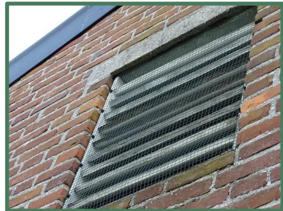
Foto 25 & 26: Ventilatioeroosters gedicht met gaas.
