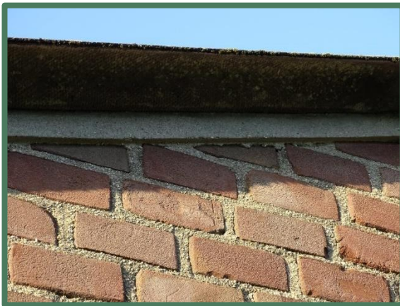
Foto 23 & 24: Randen kopgevels aangesmeerd of voorzien van boeiboord met panlatten.
