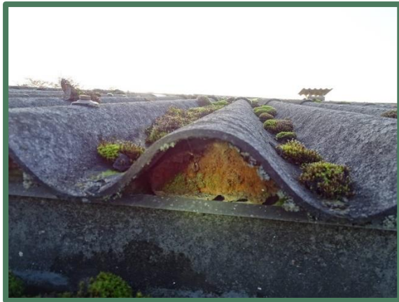
Foto 21 & 22: Openingen onder golfplaten gedicht met (oud) purschuim of vogelschroot met muurplaat.
