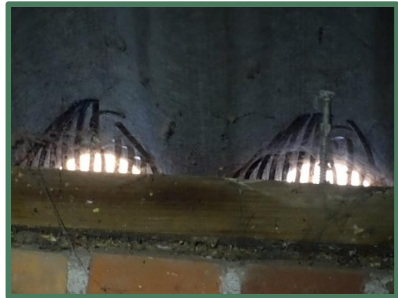
Foto 21 & 22: Openingen onder golfplaten gedicht met (oud) purschuim of vogelschroot met muurplaat.
