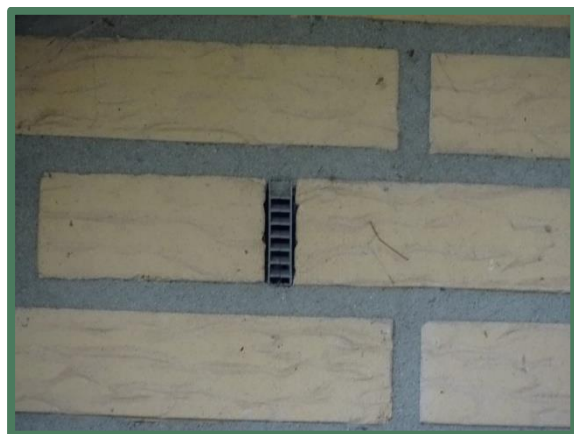
Foto 19: Stootvoeg voorzien van een bijenbekje.
