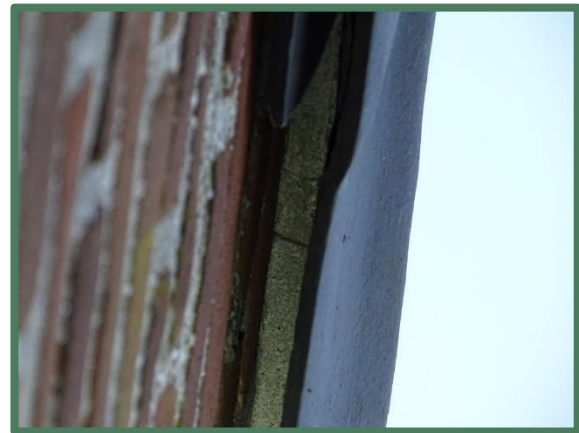
Foto 23 & 24: Randen kopgevels aangesmeerd of voorzien van boeiboord met panlatten.
