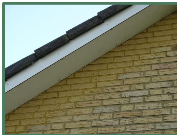
Foto 20: Kantpannen kopgevel woning en strak aangesloten overstek.
