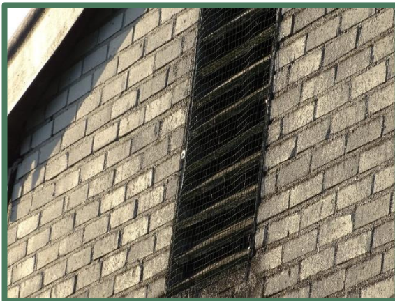
Foto 25 & 26: Ventilatioeroosters gedicht met gaas.
