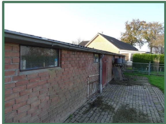
Foto 6: Oostzijde van bijgebouw ten zuiden van de woning.
