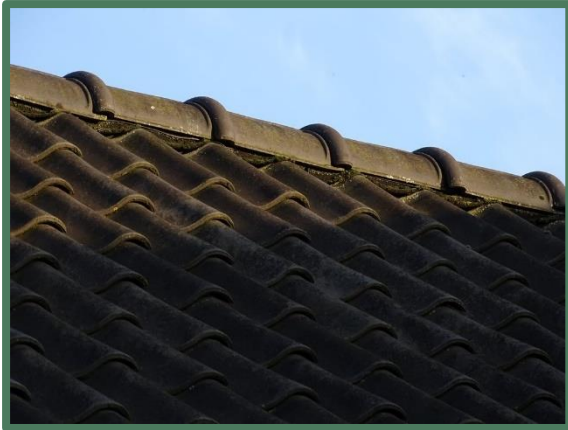
Foto 27: Strak op elkaar liggende dakpannen en openingen onder nokpannen gedicht met dakleer.
