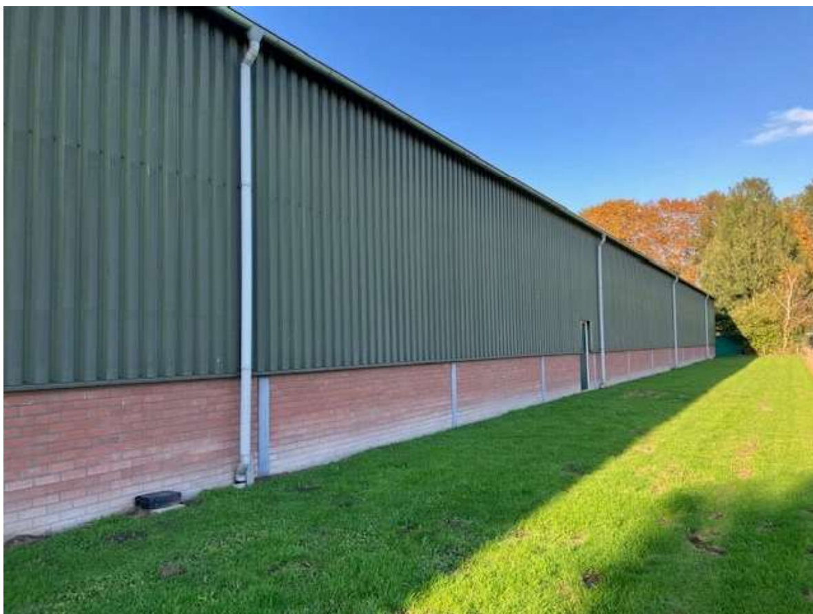
• Afbeelding 7: Zijgevel van de meest linker stal, gezien vanaf de straat
