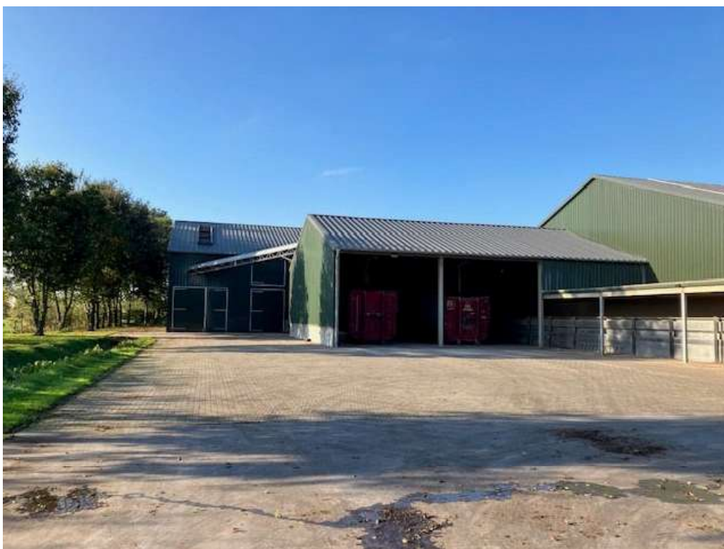
• Afbeelding 12: Erf aan de achterzijde van het bedrijf, in het midden een mestopslagloods
