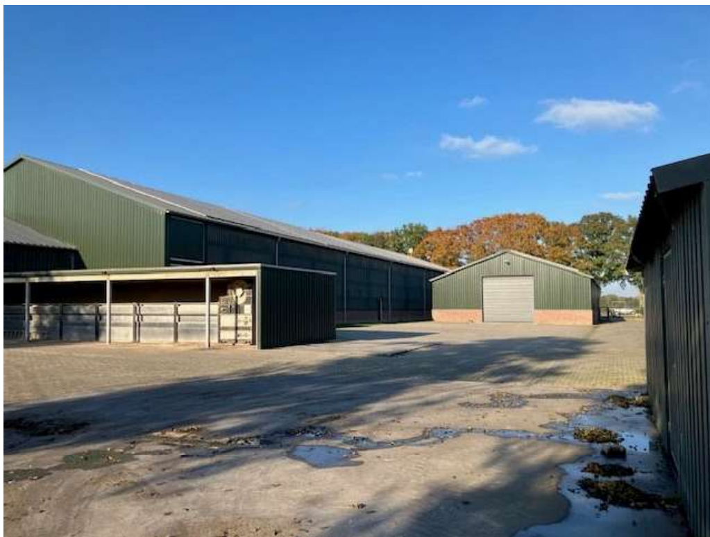
• Afbeelding 11: zicht op erf vanaf de achterzijde van het bedrijf
