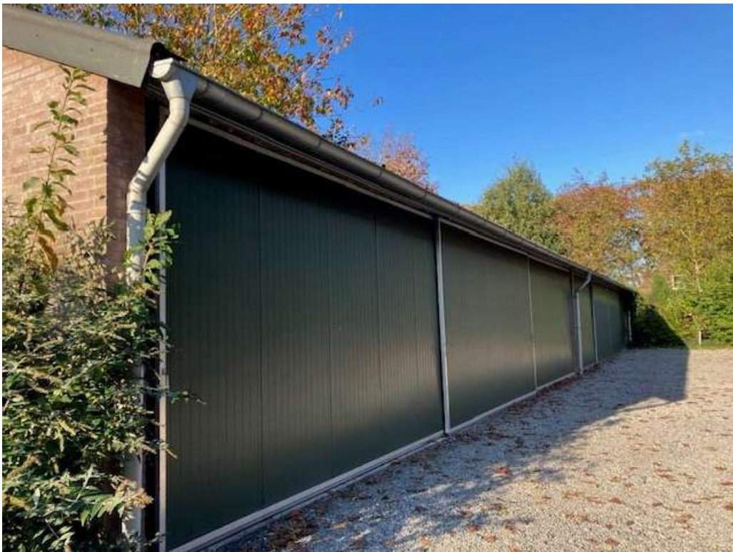
• Afbeelding 20: te slopen schuur, wordt herbouwd
