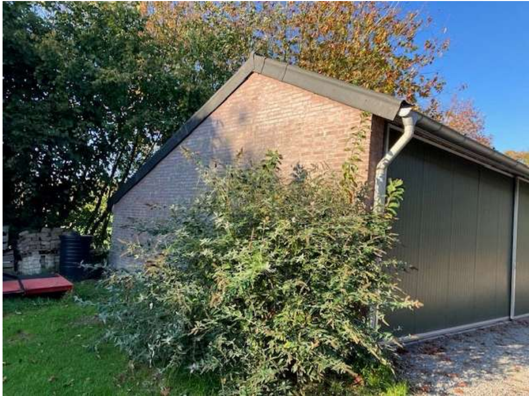
• Afbeelding 21: te slopen schuur, wordt herbouwd
