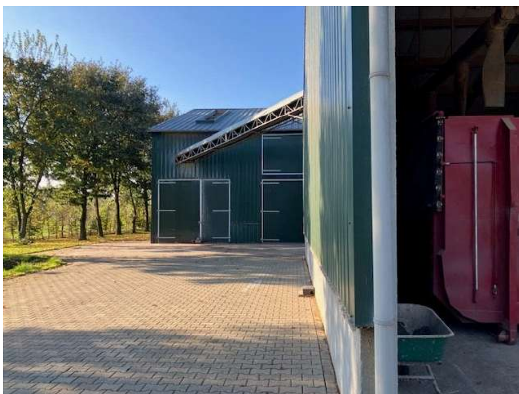
• Afbeelding 14: Achterzijde van de mestopslagloods
