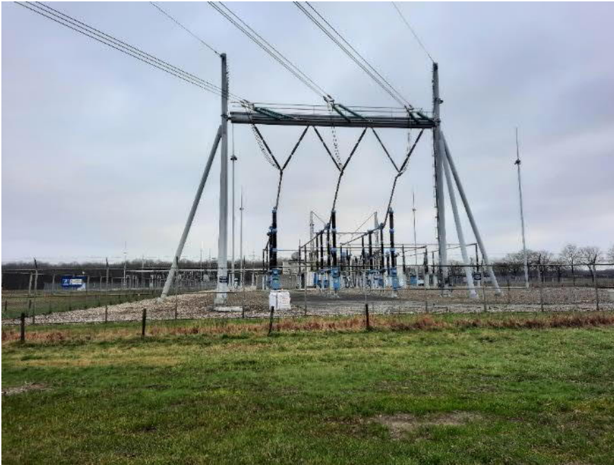
Figuur 1.3 Huidige hoogspanningsstation Boxmeer gezien vanaf de Zandkant.
