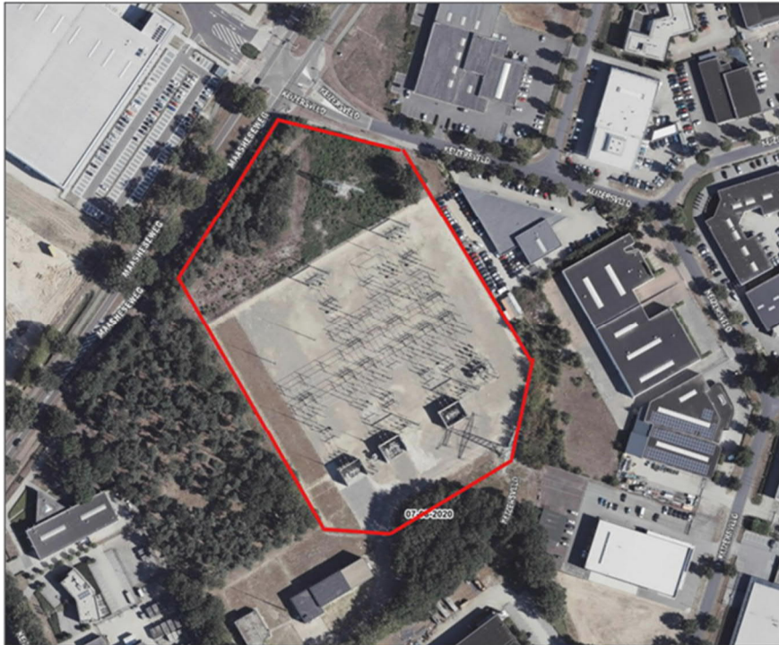
Figuur 1.1 Ligging hoogspanningsstation (rood omkaderd) in Venray.
