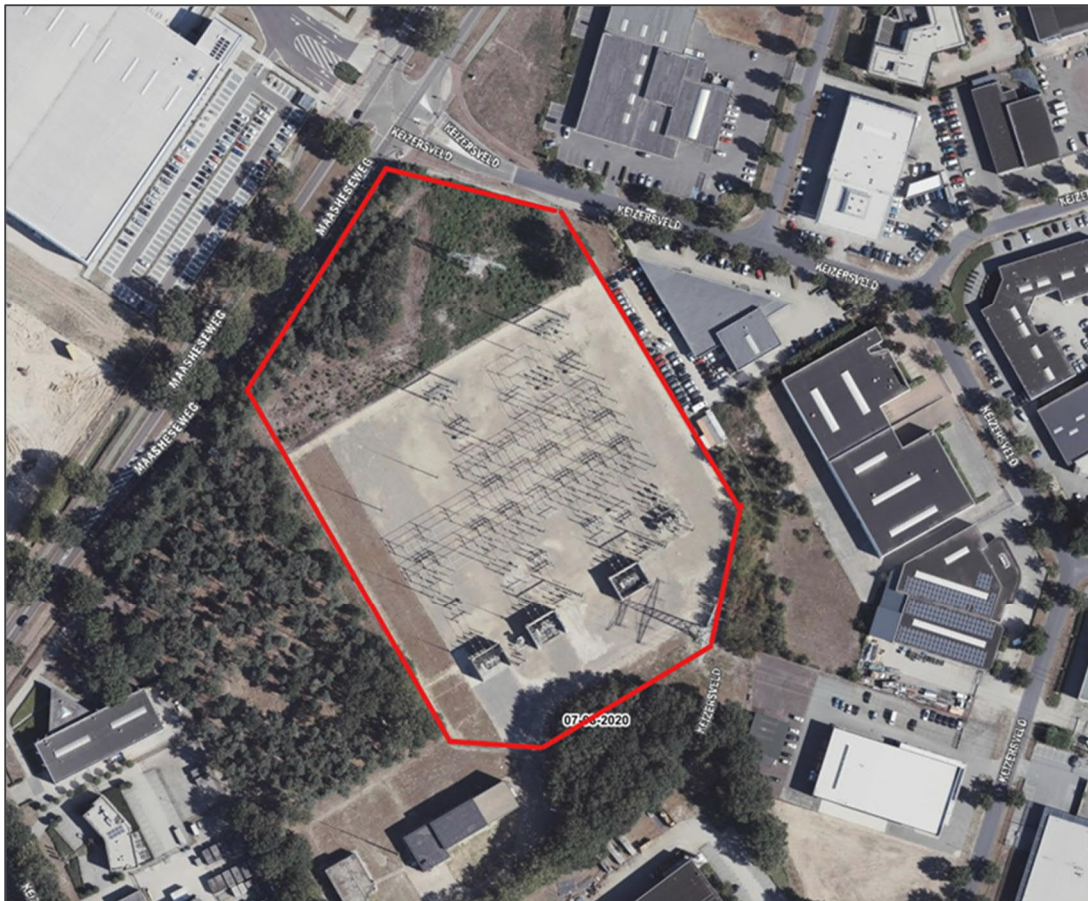
Figuur 1.2 ligging hoogspanning station (rood omkaderd) in Venray
