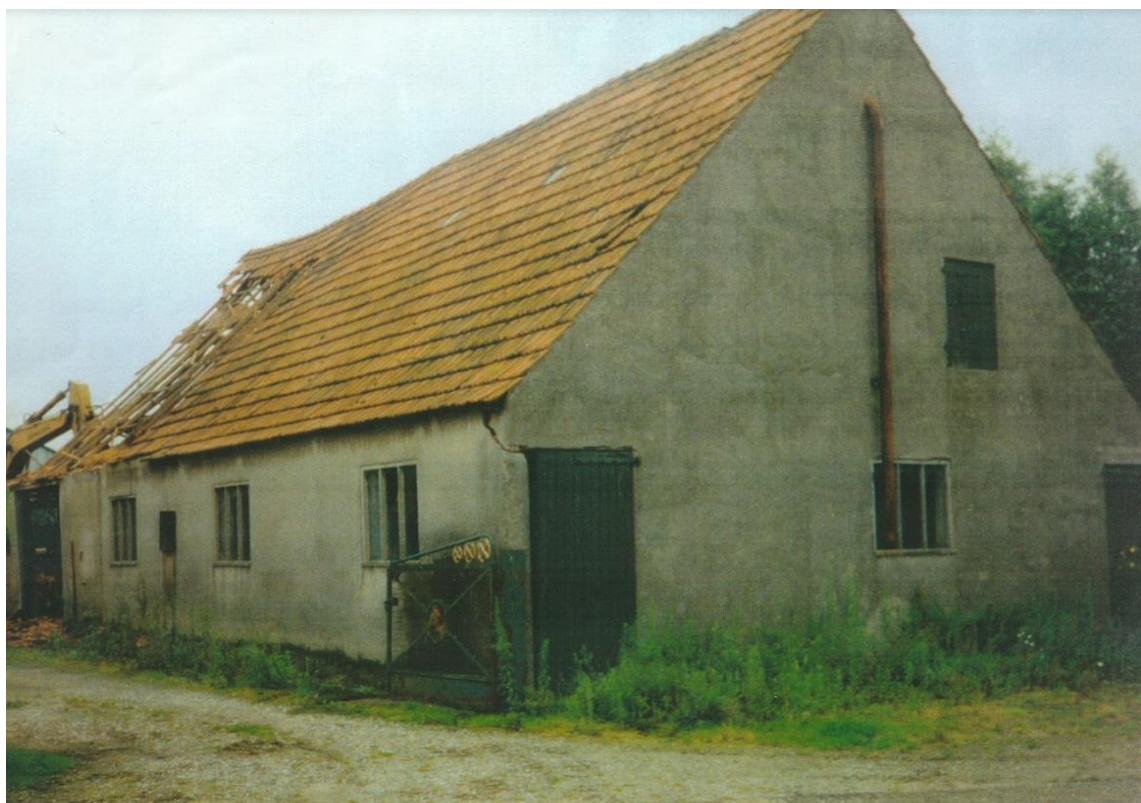
Figuur 14. Vooraanzicht van de voormalige varkensstal. Sloopwerken zijn reeds gestart. (1998)
