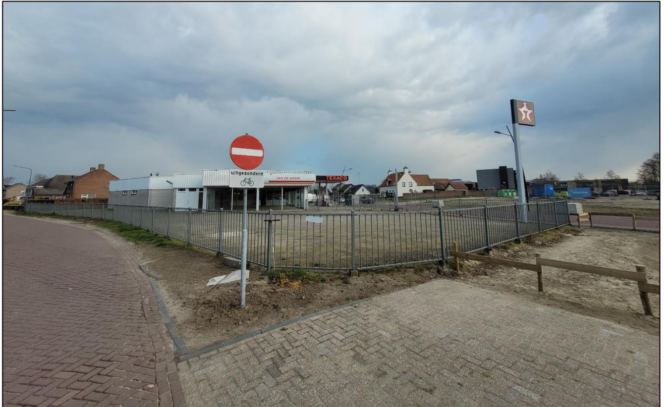
Figuur 7: Zicht op de locatie Breestraat 5, kijkend richting het zuiden (Foto: 14 april 2021).
